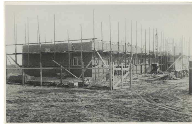
afb. 11 De 2 de Van Zeggelenschool aan de Anna Kaulbachstraat in aanbouw (bron: Noord-Hollands Archief, NL-HlmNHA_Hrlm_17742).
