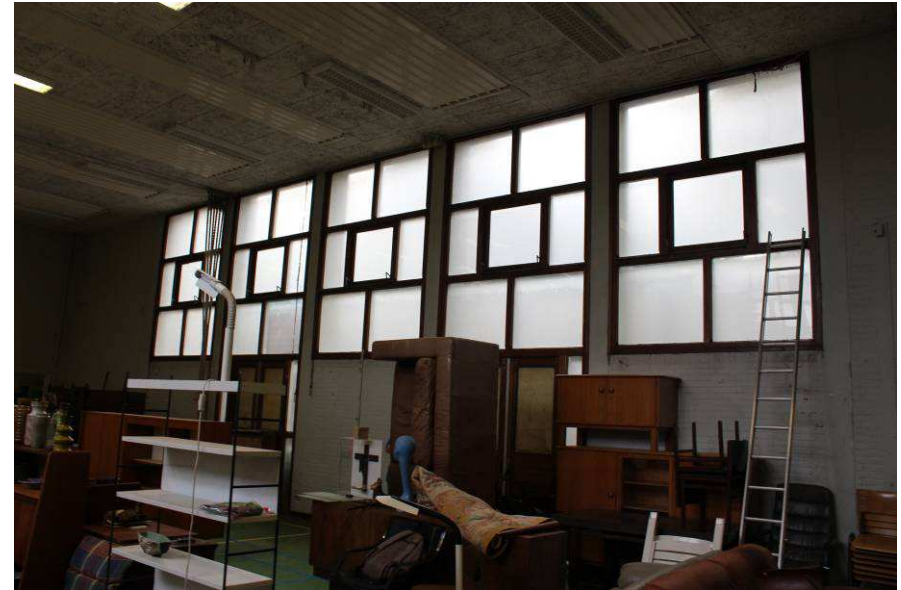
afb. 45 Interieur van de grote hal (zuidgevel).
