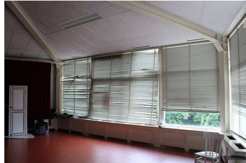
afb. 36 Interieur van het speellokaal van de kleuterschool.
