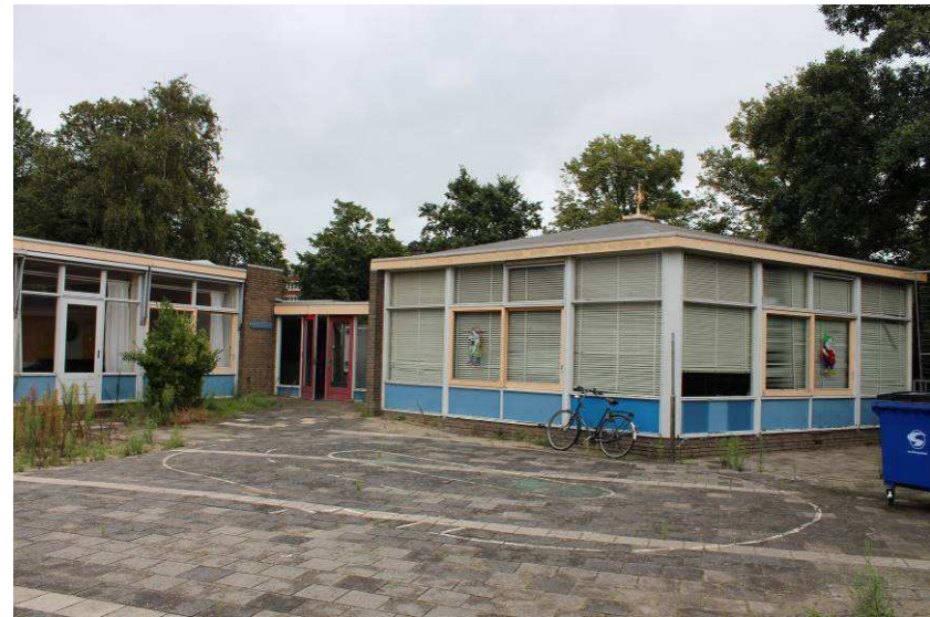
afb. 41 Westgevel van het speellokaal van de kleuterschool.
