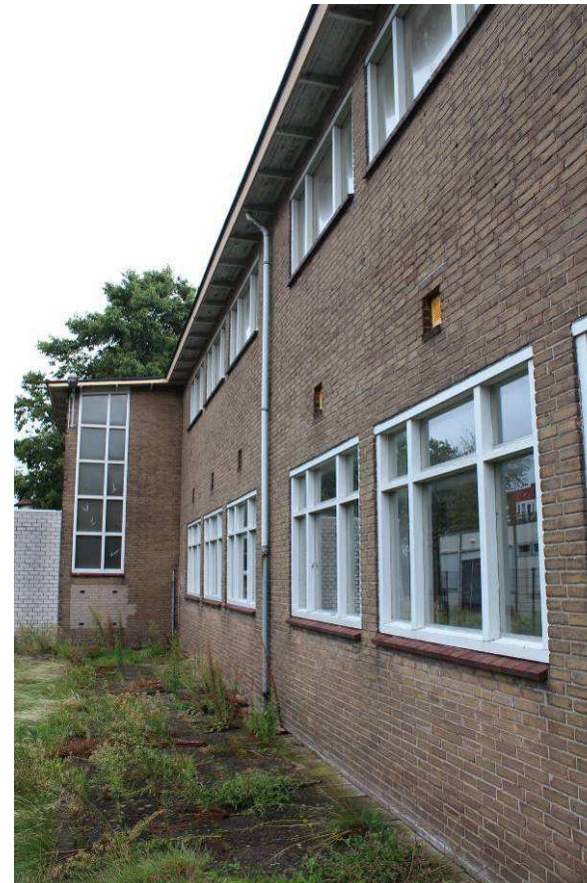
afb. 30 Westgevel van de Van Zeggelschool.
