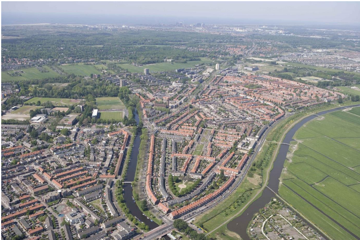
Afbeelding 1: bestemmingsplangebied gezien in noordelijke richting
