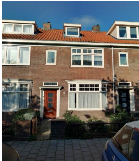
Afbeelding 10: rechts – woning in hetzelfde blok, tevens van architect Heidstra, gebouwd in 1950. Cyclomedia ©
