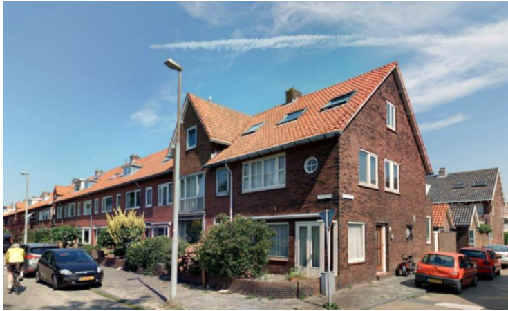
Afbeelding 11: woonblok langs de Jan Gijsenkade. Bron: Cyclomedia ©
