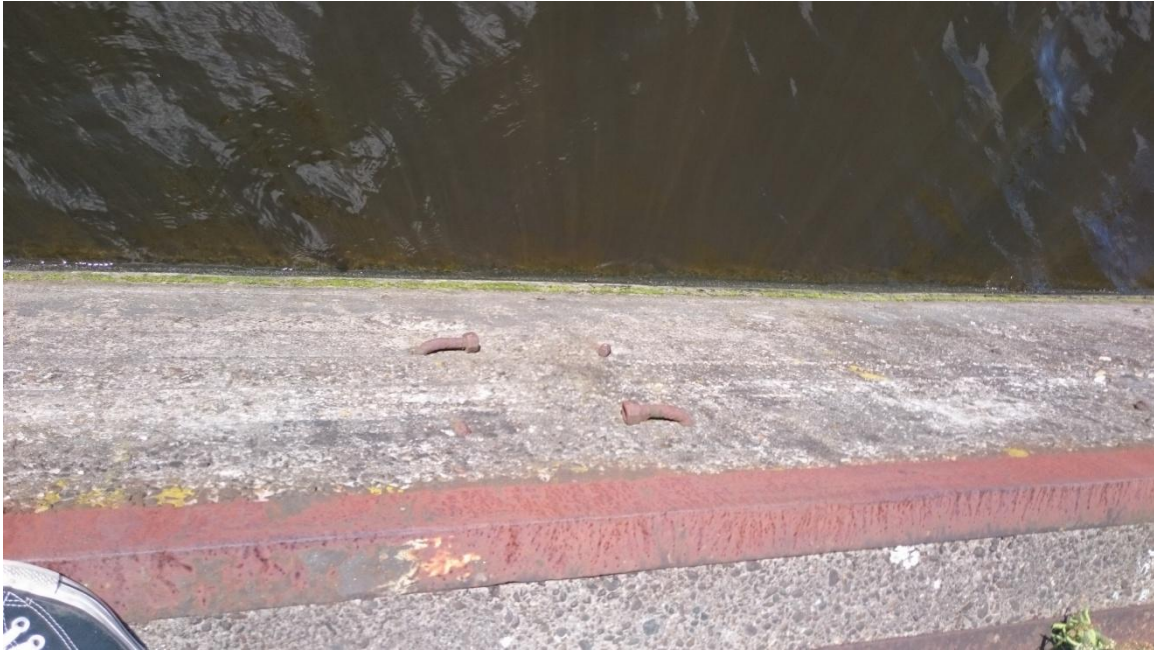
Afbeelding 2.7 Betonnen kademuur (in het noorden van het plangebied)
