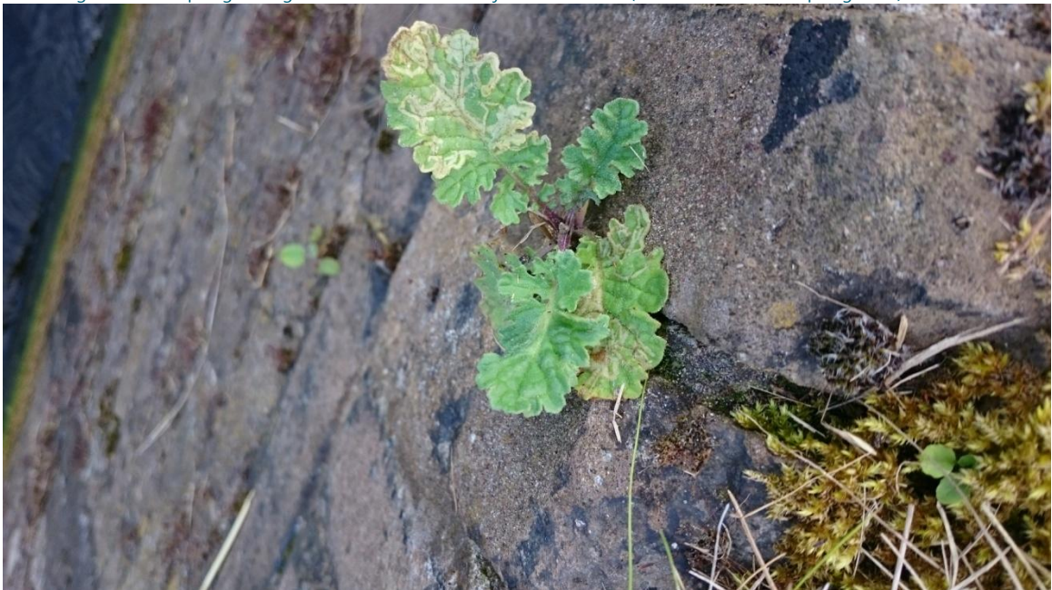
Afbeelding 2.6 Aan het plangebied grenzende kademuur met jacobskruiskruid (in het zuiden van het plangebied).
