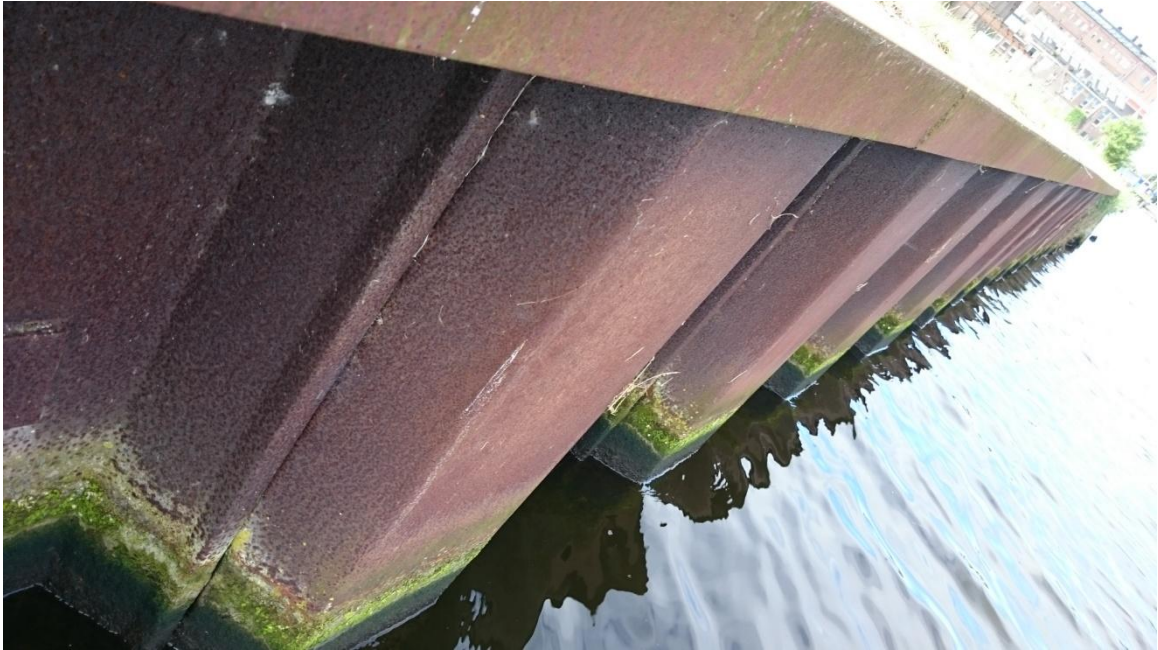
Afbeelding 2.5 Stalen damwand als kademuur (in het zuiden van het plangebied)
