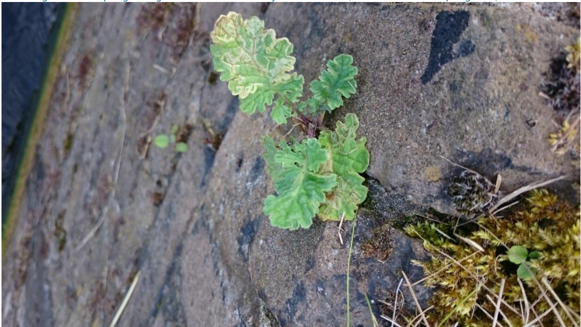
Afbeelding 2.6 Aan het plangebied grenzende kademuur met jacobskruiskruid (in het zuiden van het plangebied).
