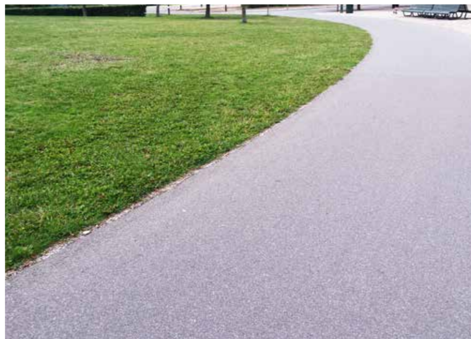
Brede paden asfalt met zichtbare steenslag
