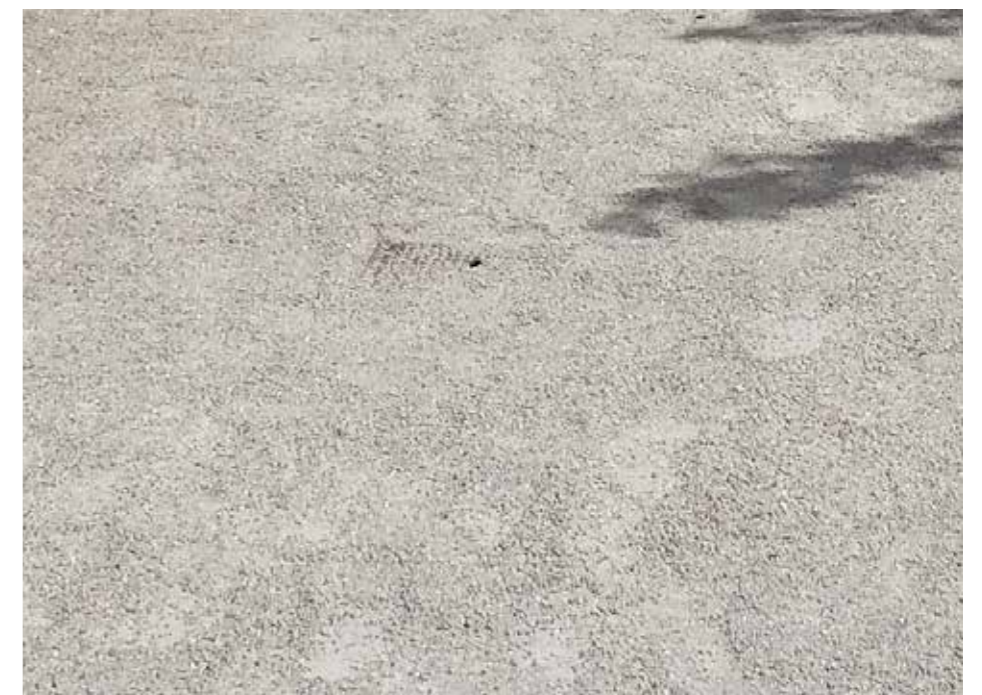
Smalle paden, gebonden halfverharding als Nobré Cal of stabilizer
