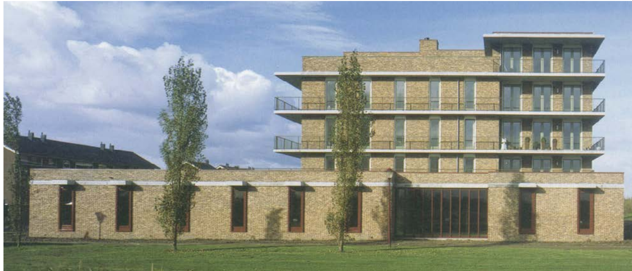
De architectuur van de nieuwe gebouwen sluit aan op de parkachtige sfeer van locatie I. Horizontale lijnen versterken het lichte karakter van de bebouwing. Een lichtvoetige uitstraling kan ook bereikt worden met een gevel die als basis baksteen heeft.
