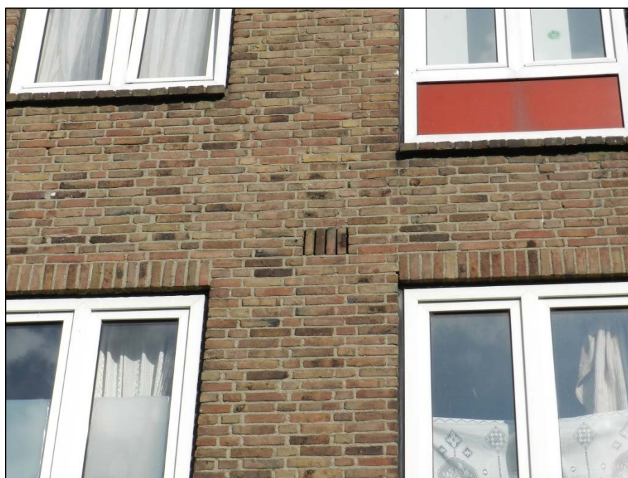
Openingen naar de spouwmuur waar een zomerverblijf van Gewone dwergvleermuis werd vastgesteld.
