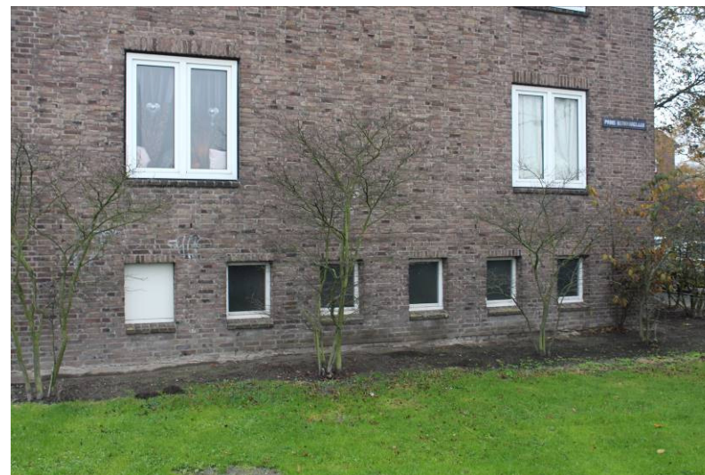
afb. 17 Kleine vensters voor daglichttoetreding naar het sousterrain
