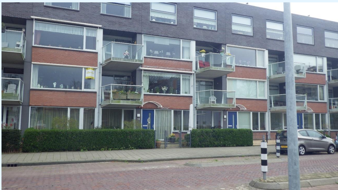
figuur 14: het appartementencomplex waar de meting heeft plaatsgevonden
