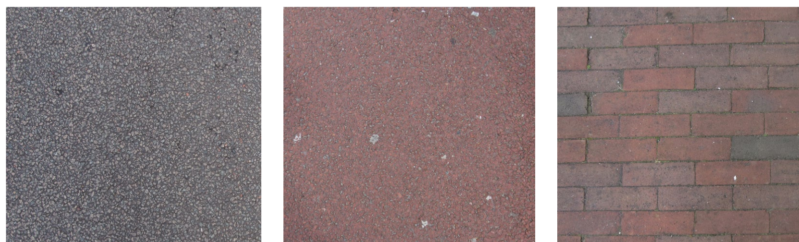
EERSTE EMMA STRAAT / KONINGINNEWEG / TEMPELIEERS STRAAT RIJWEG - ASFALT / FIETSSTROKEN - ROOD ASFALT TROTTOIR - GEBAKKEN KLINKERS (ROOD, DIKFORMAAT, HALFSTEENSVERBAND)
