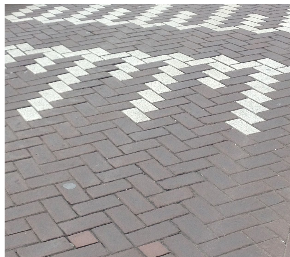
VERKEERSDREMPEL (GEKLINKERD MET INGESTRATE WEGMARKERING)
