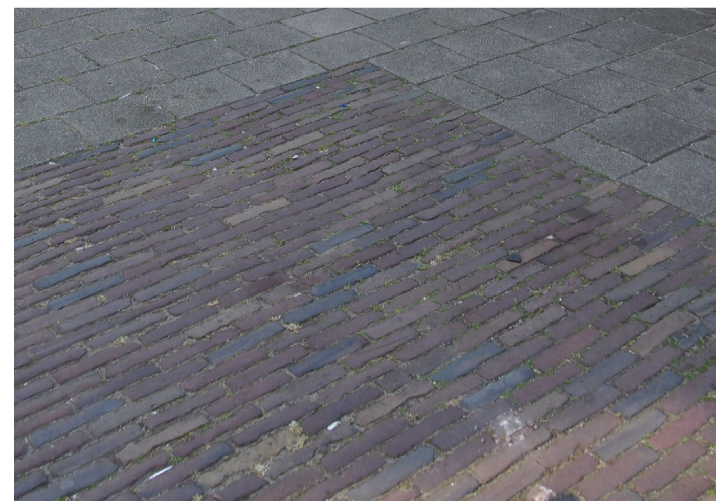
VERHARDING PLEINTJE (VLAK), GEBAKKEN KLINKERS (HERGEBRUIK) ROOD, WAALFORMAAT EN HALFSTEENSVERBAND
