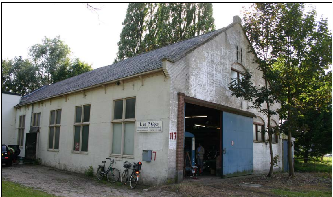
De fabriek gezien vanuit het noordoosten
