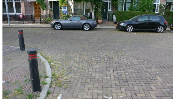
Foto 3.3.3: Voorbeeld gebakken klinkers in een woonstraat in Noord
