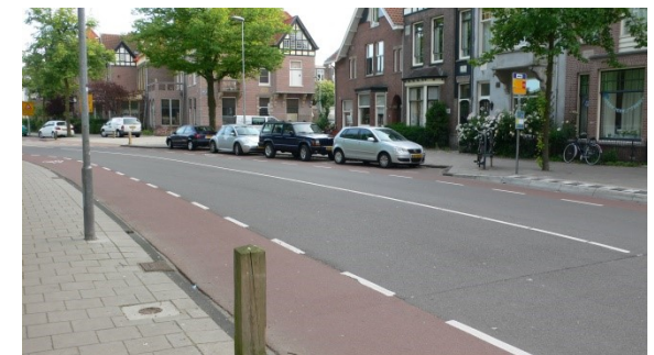
Foto 3.3.4: asfaltstraat in Noord (Ostadestraat.)
