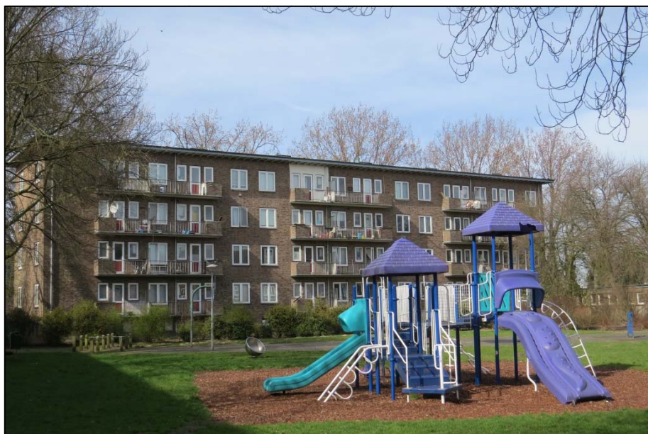
Centrale deel plangebied met speeltuin en op de achtergrond één van de flats.
