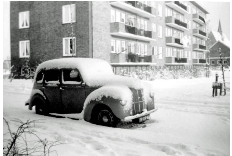
afb. 8 Deze foto uit 1957 toont de zuidelijke en oostelijke gevel van de portiekflat langs de Richard Holkade met op de achtergrond de Zuid-Oosterkerk (bron: www.haarlem-oost.nl ).
