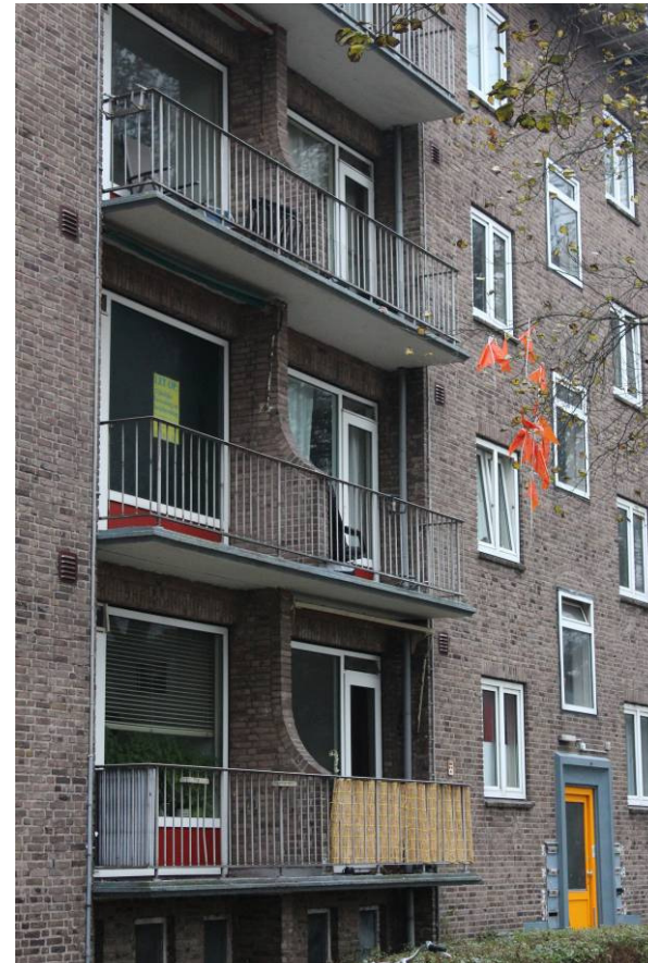
afb. 1 Dubbele balkons van een bouwblok aan de zijde van de Richard Holkade
