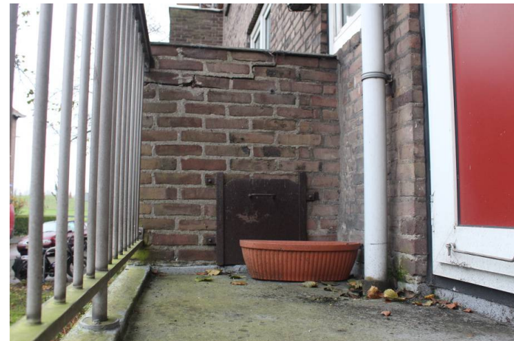
afb. 14 Gemetselde kolenopslag met ijzeren schuifdeurtje
