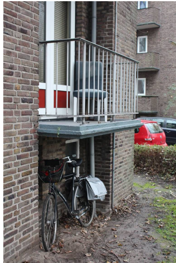
afb.2 Betonnen balkon aan de straatzijde van het bouwblok aan de Richard Holkade
