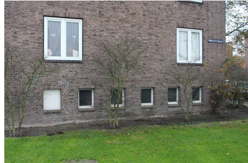
afb. 17 Kleine vensters voor daglichttoetreding naar het sousterrain
