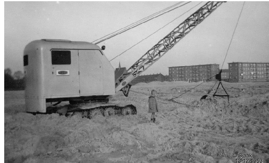
afb. 6 Foto uit 1953 genomen op het moment dat grondwerkzaamheden werden uitgevoerd ten behoeve van de bouw van de portiekwoningen aan de Hannie Schaftstraat. Op de achtergrond zijn de portiekflats aan de Richard Holkade en Henriëtte Bosmanstraat te zien (bron: www.haarlem-oost.nl ).
