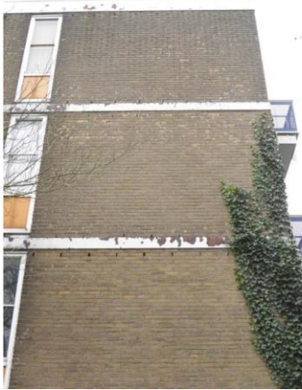
Afb. 14 De appartementencomplexen zijn voorzien van spouwgoten
