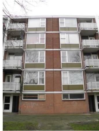
Afb. 15 Wanneer de scheur in deze muur toegang biedt tot de spouwruijme dan vormt het een potentiële verblijfplaats voor vleermuizen
