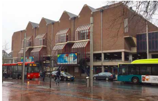
Logge Beijneshal en parkeergarage belemmeren het zicht richting het centrum
