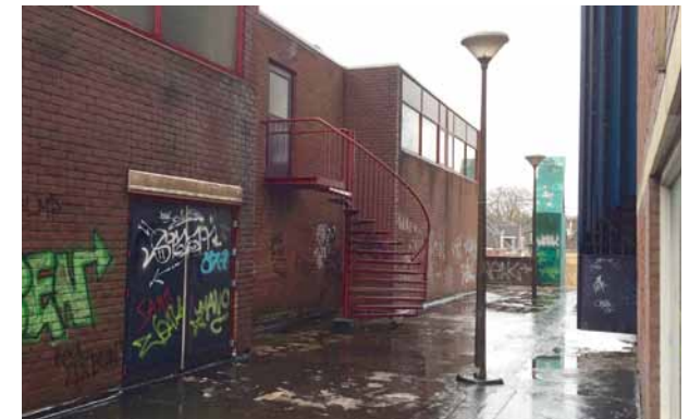
Ongure openbare ruimte rond de Beijneshal
