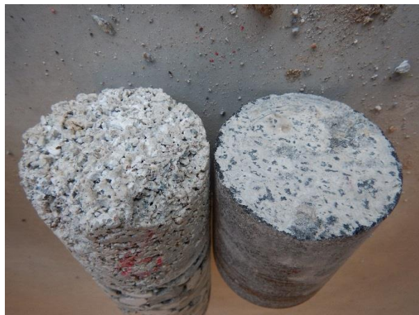
Figuur 1.6: Hechtvlak steen / splitbeton locatie 6
