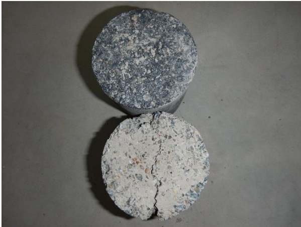
Figuur 1.1: Hechtvlak steen / splitbeton locatie 1
