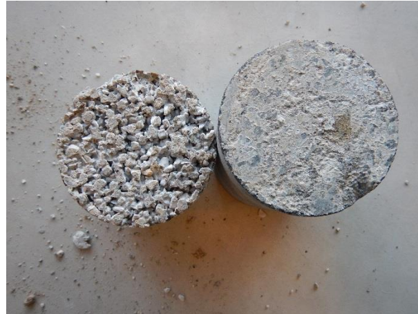
Figuur 1.8: Hechtvlak steen / splitbeton locatie 8
