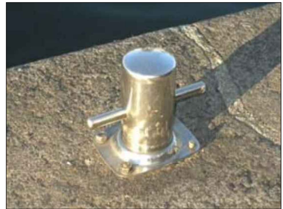
Principe bolder op kademuur Conform NEN 1072: - rvs lasbolder - hoogte: 160 mm - diameter: 104 mm
