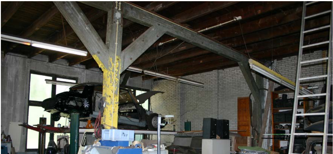
De onderslagconstructie uit 1921
