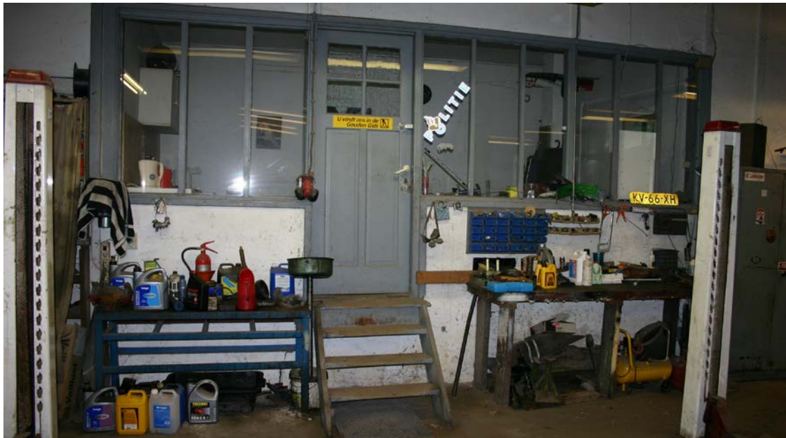
De in 1921 geplaatste onderslagconstructie en wand met kantoorpui
