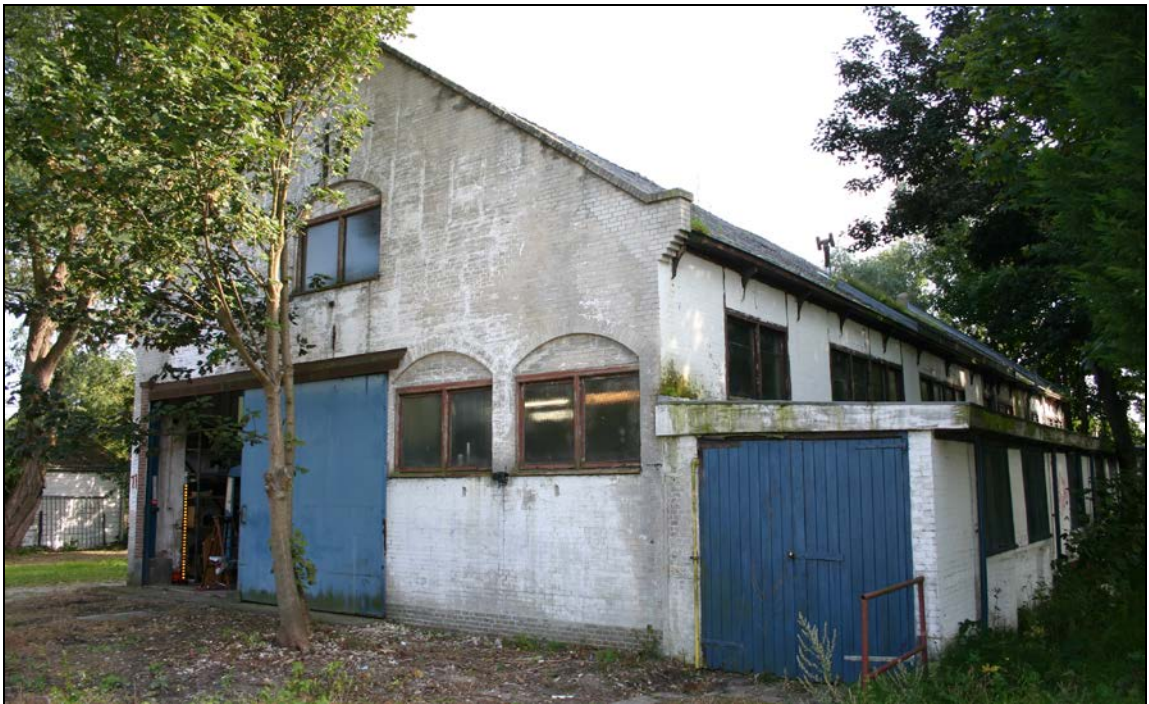
De fabriek gezien vanuit het noordwesten
