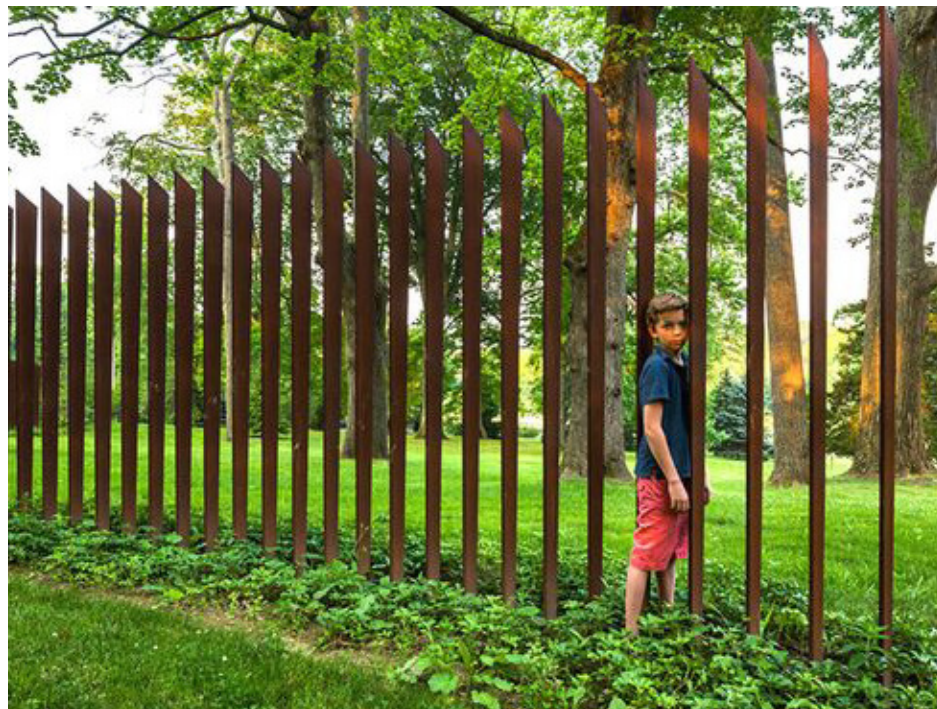
In de openingen komen stalen tralielamellen die als je recht van voren kijkt zorgen voor transparantie. Kijk je schuin (met de muur mee) dan sluit de muur zich visueel juist.
