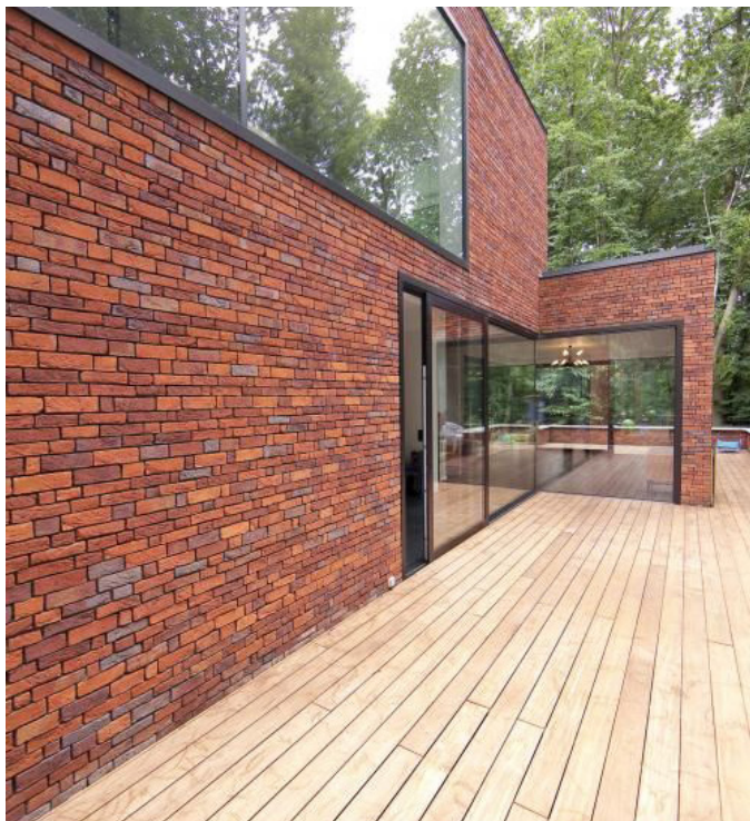
Referentie relatie dek met nieuwe metselwerk gebouwen
