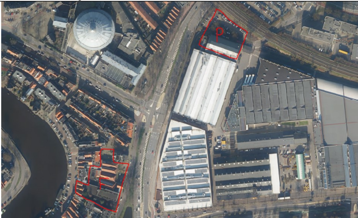
Fietsenfabriek en terrein van Nedtrain aan de Gedempte Oostersingelgracht
