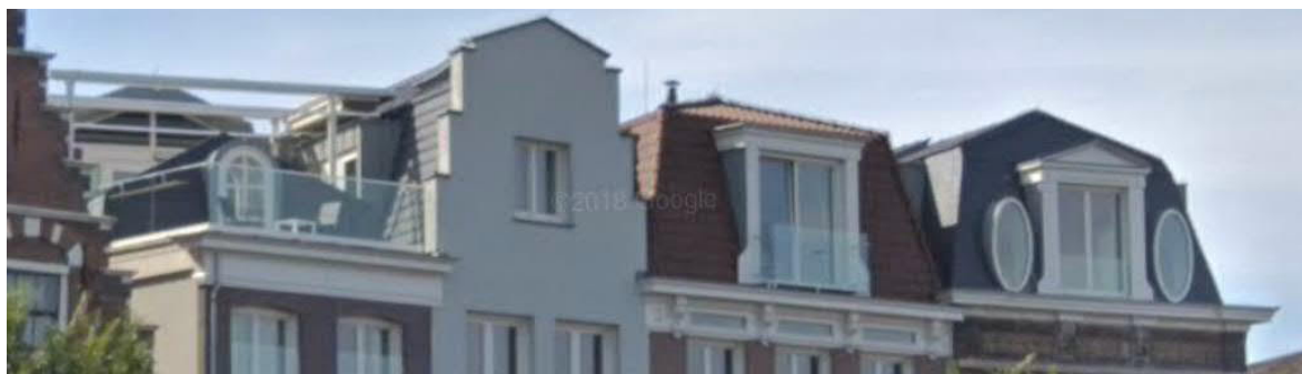
FIGUUR 5: SPAARNE 84 EN 86, OPGETROKKEN MODERNE KAP OP EEN HISTORISCH EN HISTORISERENDE GEVEL
