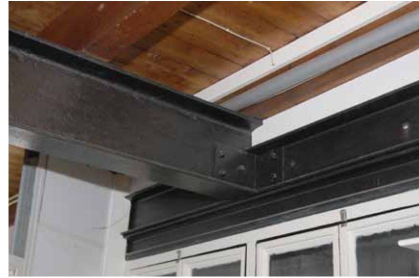
afb.22: houten onderslag in het oude bouwdeel en ijzeren onderslag in het nieuwere deel
