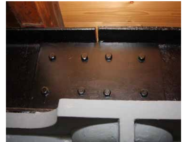
afb. 18: koppeling van twee balken
