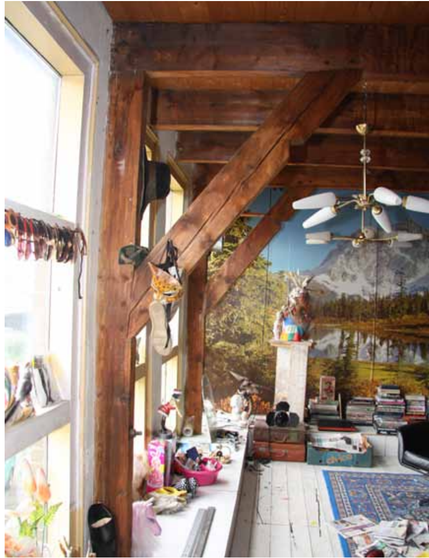
afb.19: muurstijlen en korbelen op de tweede verdieping van het jongste bouwdeel
