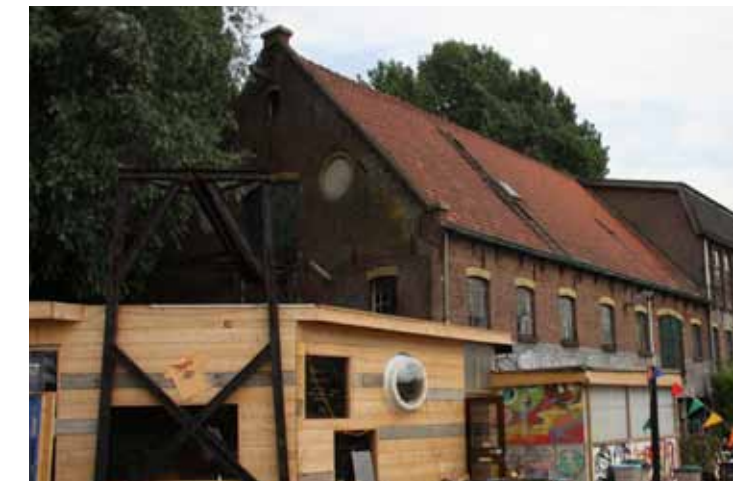
afb.11: achtergevel met staalconstructie en tijdelijke aanbouw juli 2010
