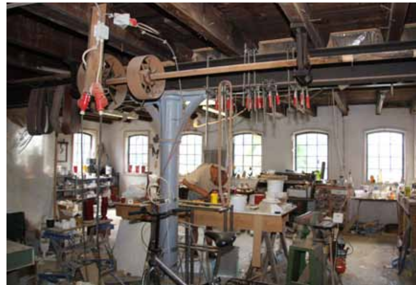
afb. 15: eerste verdieping voorste bouwdeel met ijzeren onderslag en gietijzeren kolom
