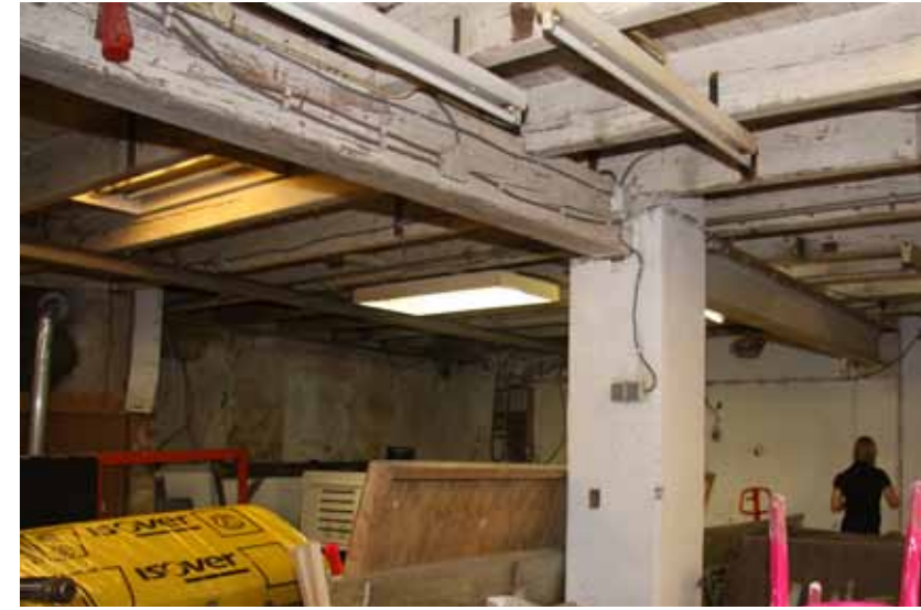
afb.22: houten onderslag in het oude bouwdeel en ijzeren onderslag in het nieuwere deel
