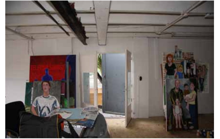
afb.32: links de zwarte kraanbaan, bij de deur loopt hij naar buiten naar het laadperron
