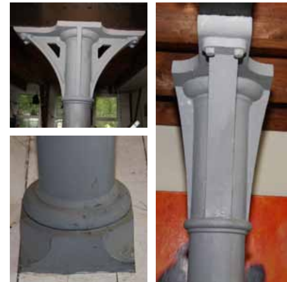
afb. 16: detail kolom: aangegoten consoles en basement
