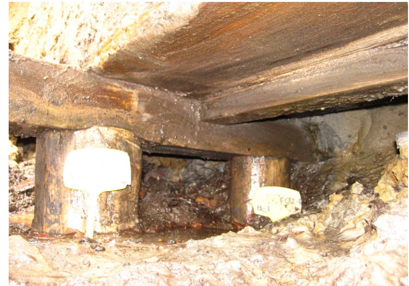
Kesp 1: Paal A links en Paal B rechts
