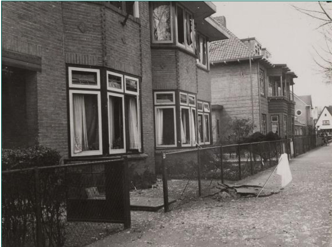
Figuur 42: Inslagopening blindganger voor Adriaan Pauwlaan 21 (Bron: Beeldbank NHA, fotonr. KNA003004473).
