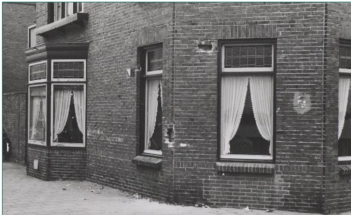
Figuur 53: Kogel- en granaatinlagen in het hoekhuis Floresstraat-Spaarndamseweg (Bron: Beeldbank NHA, fototr. NL-HlmNHA_Hrlm_20871).
