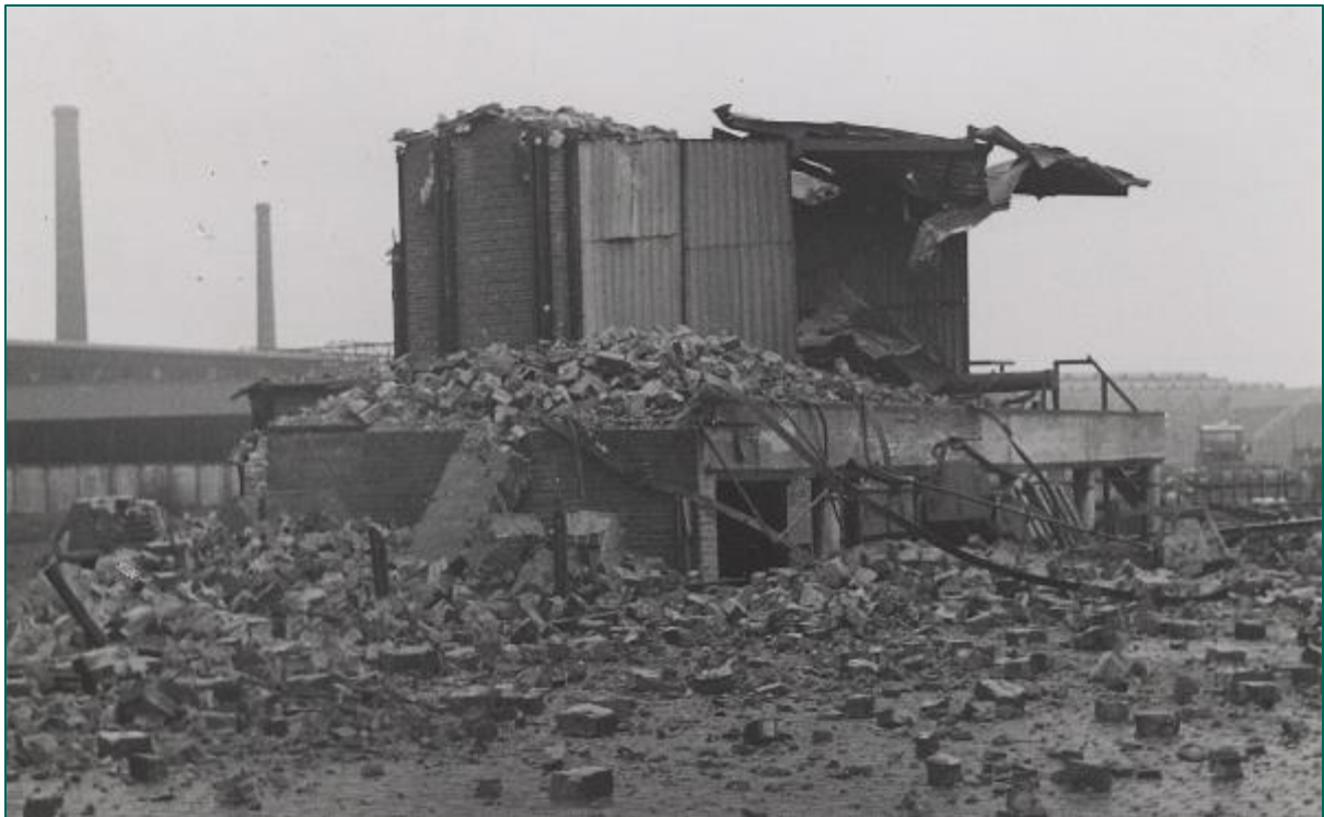
Figuur 38: Bominslag op de verbrandingsoven (Bron: Beeldbank NHA, Fotonummer NL-HImNHA_54008304).
