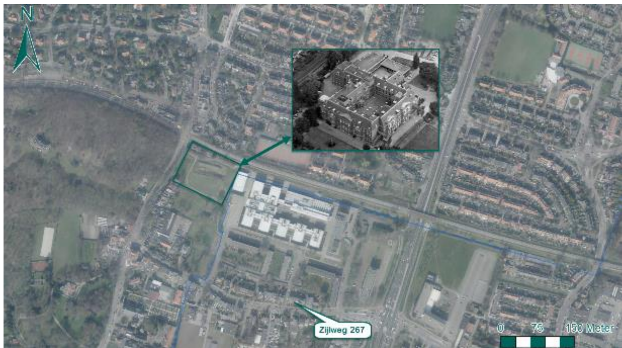
Figuur 89: Marinecomplex Overveen nabij Zijlweg 267.
