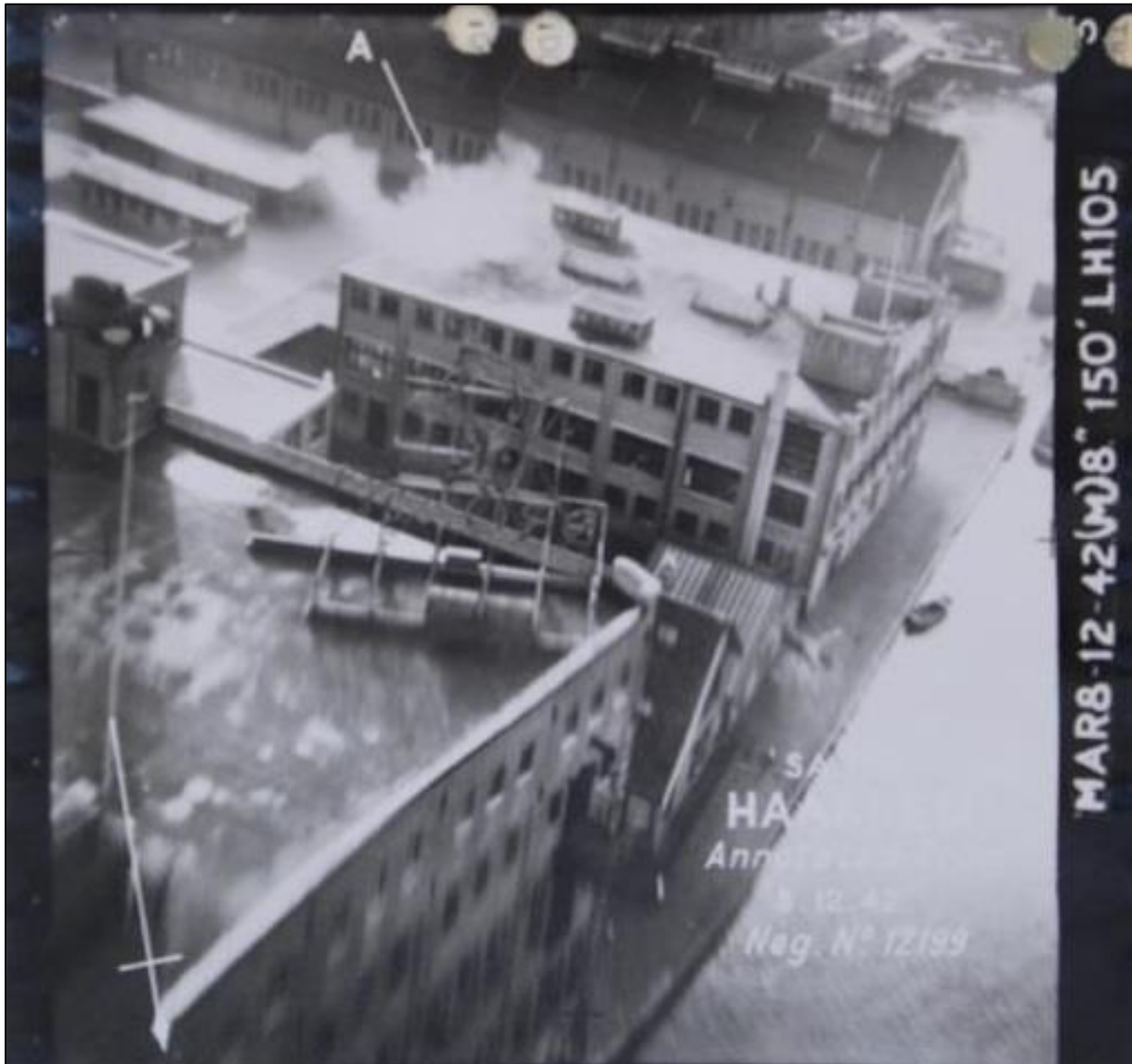
Figuur 68: Bominslag op de Drostefabriek, 8 december 1942, aangegeven met de letter 'A' (bron: NARA, RG243).
