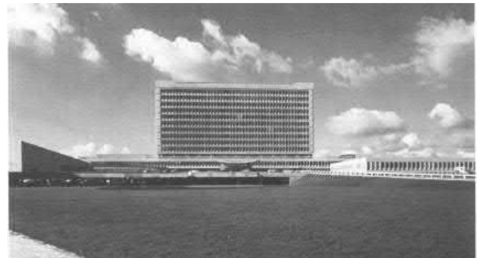
Het breedvoettype toegepast door K.L. Sijmons bij het Ziekenhuis Leyenburg in Den Haag, gereed gekomen in 1971. Uit: Architectuur voor de gezondheidszorg in Nederland . Rotterdam 2010
