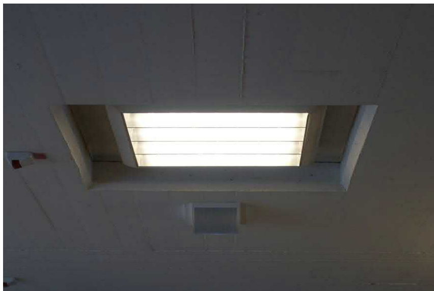
De uitsparing in het plafond voor een plafonddlamp. FH MAB 2019
