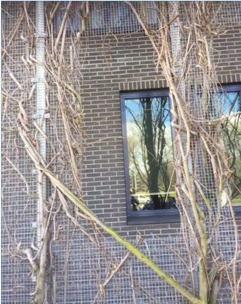
figuur 9: achterkant van hoofdgebouw, stootvoegen die zeker in de winter vrij toegankelijk zijn voor vlermuizen
