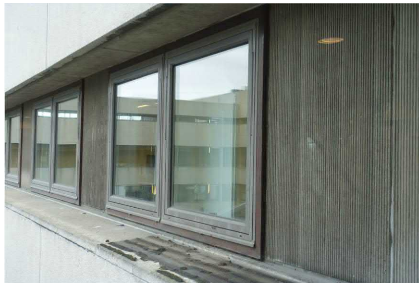
Bij de verdiept gelegen vensterstroken in de noordgevel zijn ter weerszijden van de vensters geribbelde prefab betonelementen gebruikt. FH MAB 2019
