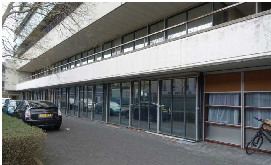
Gebouw 3 van het beddenhuis, begane grond en eerste verdieping van de zuidgevel. FH MAB 2019
