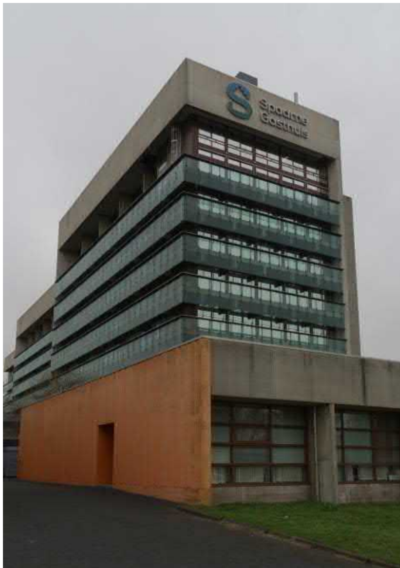
Gebouw 3 van het beddenhuis vanuit het zuid-oosten. De laagbouw op de voorgrond is in 2004 ingekort. FH MAB 2019
