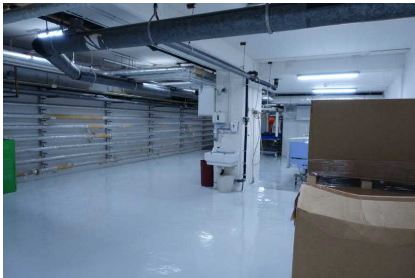
Kelder in gebouw 1 naar het westen gezien. FH MAB 2019
