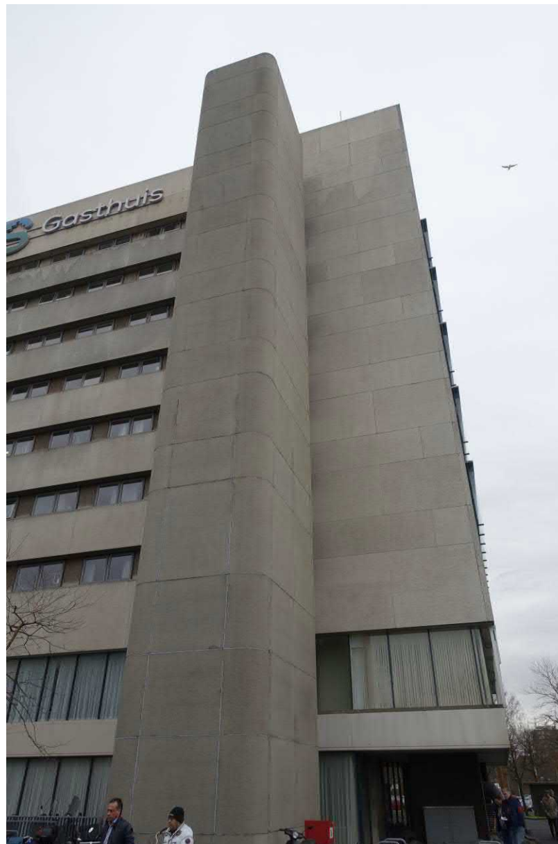
Gebouw 1 van het beddenhuis, rechter deel noordgevel en noodtrappentoren. FH MAB 2019
