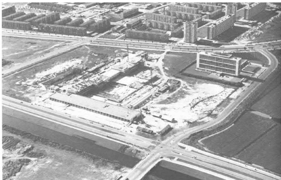
Stand van de bouw van het ziekenhuis op 30 september 1967. Bron: 400 jaar Gasthuis, 1981
