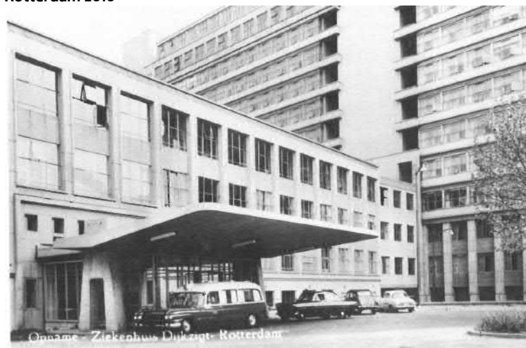
Bij het Dijkzigt Ziekenhuis in Rotterdam was de entree voor de ambulances net als bij de oorspronkelijke opzet van het St. Elisabeths Gasthuis in Haarlem ondergebracht in het behandelhuis, met een grote betonnen luifel. Uit: Architectuur voor de gezondheidszorg in Nederland . Rotterdam 2010
