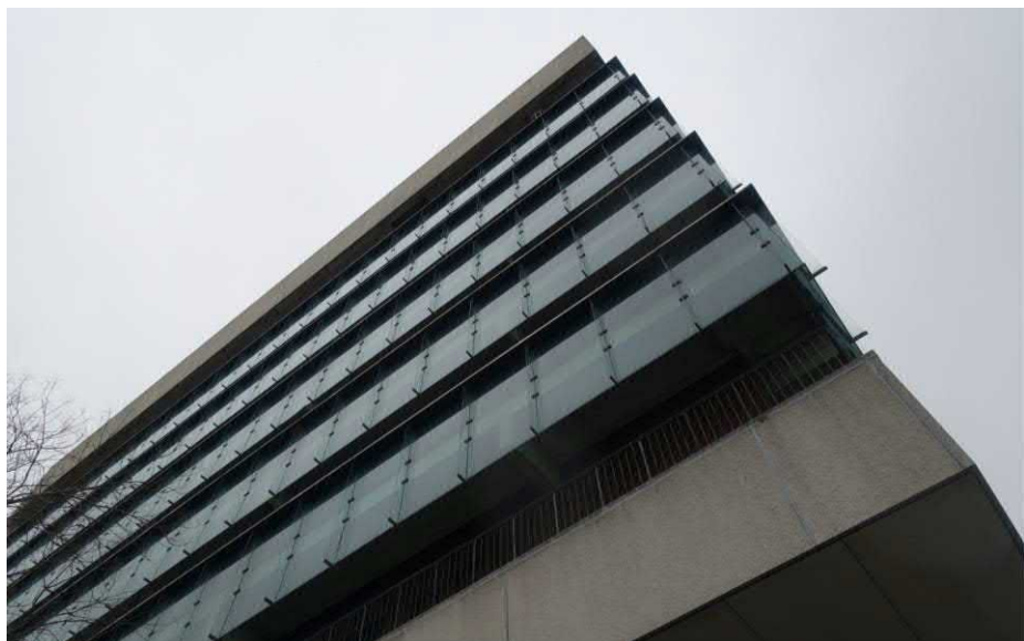
Gebouw 3 zicht langs zuidgevel naar boven. FH MAB 2019
