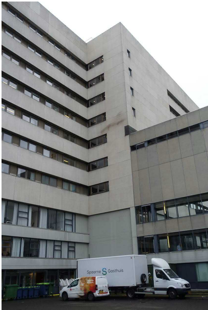
Gebouw 3 van het beddenhuis, zicht op de rechter helft van de noordgevel vanuit de verdiept gelegen binnenplaats. De onderste laag is hier de kelder. FH MAB 2019
