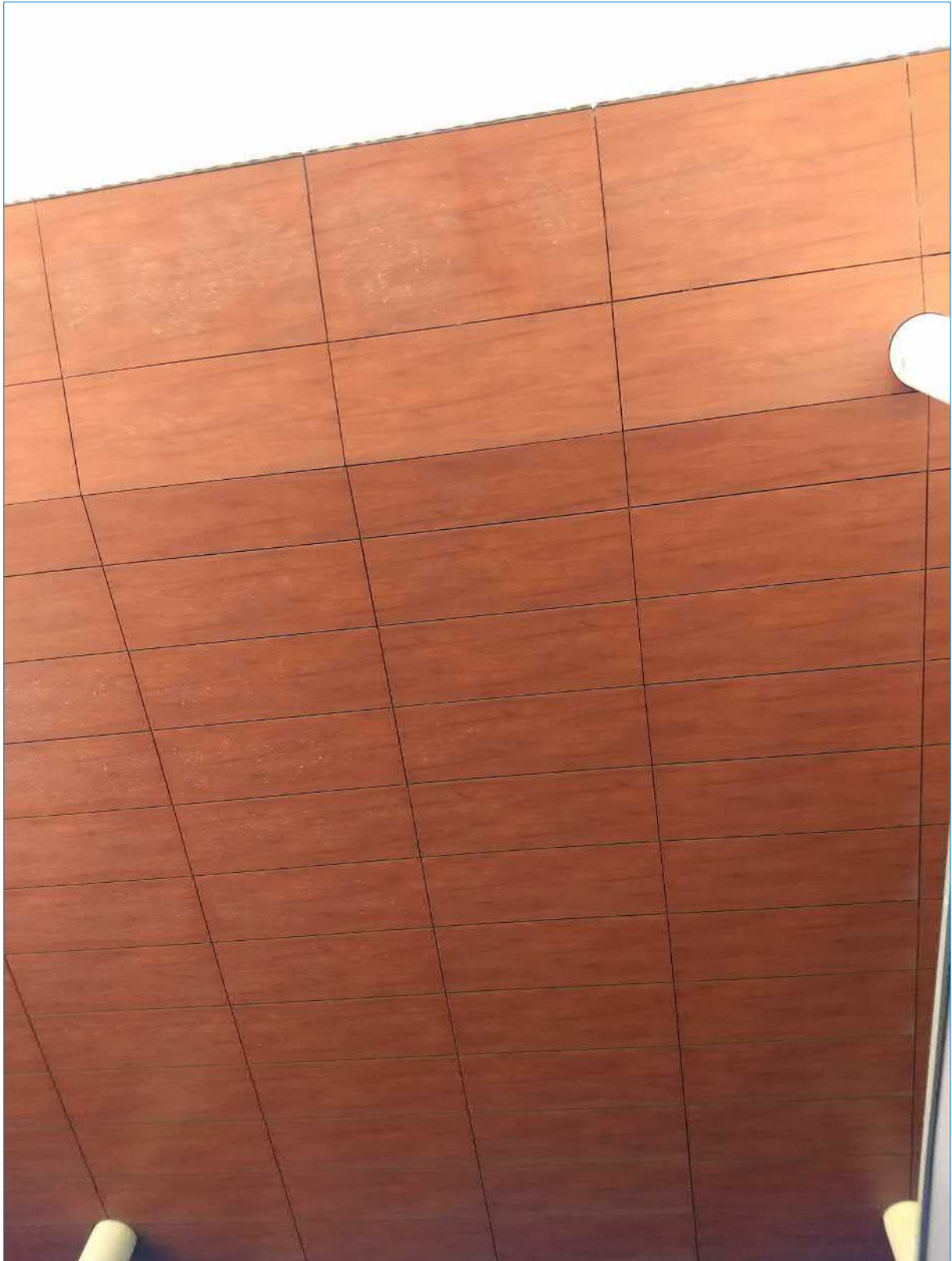
figuur 13: planfondbeplating met ruimte tussen de platen
