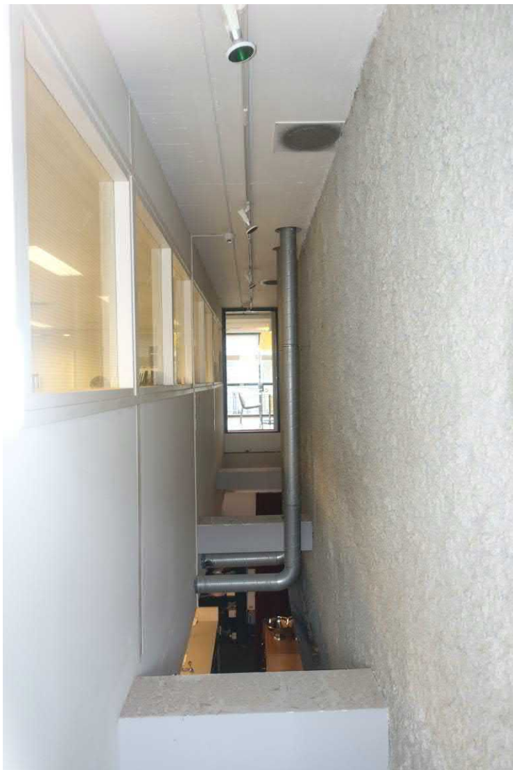
Zicht door een smalle ruimte op de verdieping in gebouw 2 die ligt tussen het amfitheater (ruwe wand rechts) en de voormalige kapel die links lag. Op begane grondniveau was in deze ruimte een vijver. FH MAB 2019
