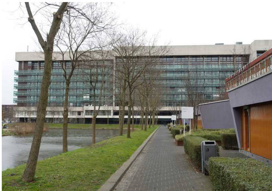
Het beddenhuis vanuit het zuiden. FH MAB 2019
