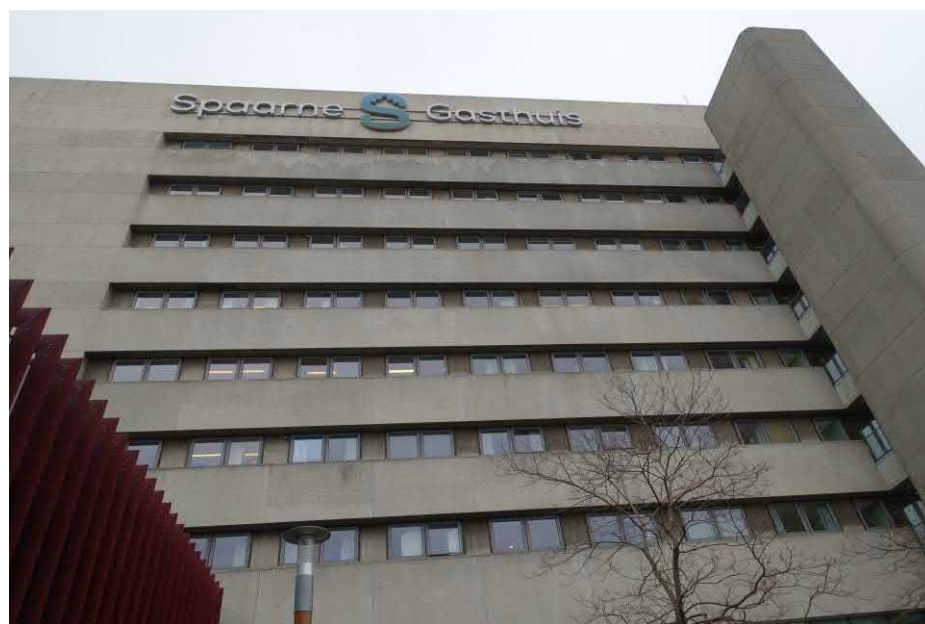
Gebouw 1 van het beddenhuis, zicht op de noordgevel. FH MAB 2019
