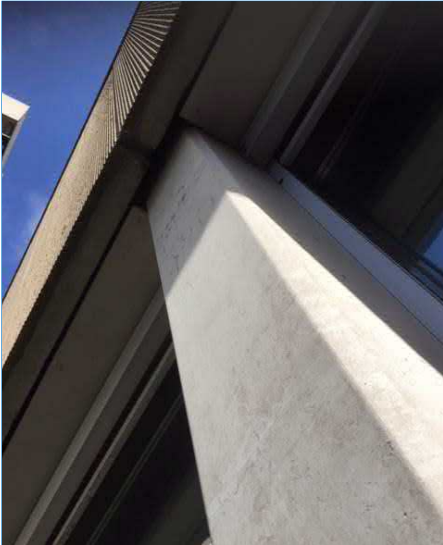
figuur 7: ruimte achter de gevelbeplating bij het mortuarium
