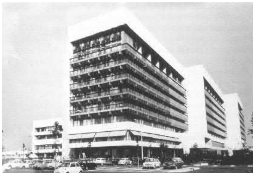
Boven: Het Sint Franciscus Gasthuis Rotterdam van Kraaijvanger (1975) en onder het Sint Elisabeth's of Groote Gasthuis in Haarlem van Kruisheer en Hallink (1971). Uit: Architectuur voor de gezondheidszorg in Nederland. Rotterdam 2010
