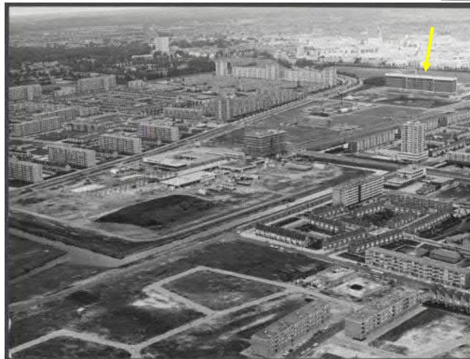
Het stadsdeelcentrum in aanbouw, circa 1970/71, gezien naar het noordwesten. De gele pijl wijst naar het net voltooide beddengebouw van het St. Elisabeths Gasthuis (Nationaal Archief, inv.nr. 480018-014).
