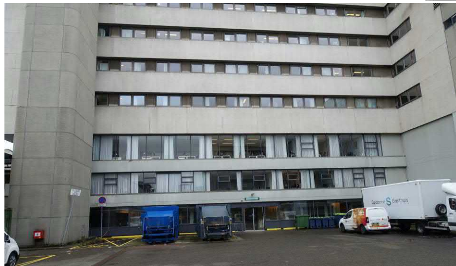
Gebouw 3 van het beddenhuis, zicht op de onderbouw van de noordgevel vanuit de verdiept gelegen binnenplaats. De onderste laag is hier de kelder. FH MAB 2019
