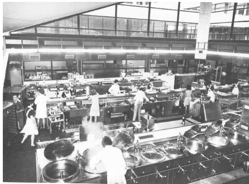
De verdiept op het binnenterrein gebouwde keuken nog in vol bedrijf rond 1980. Bron: 400 jaar Gasthuis, 1981
