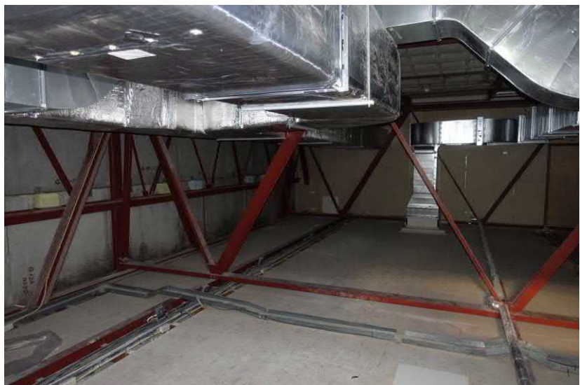
Een zolderruimte met stalen vakwerkliggers in gebouw 2 naar het noordoosten gezien. FH MAB 2019
