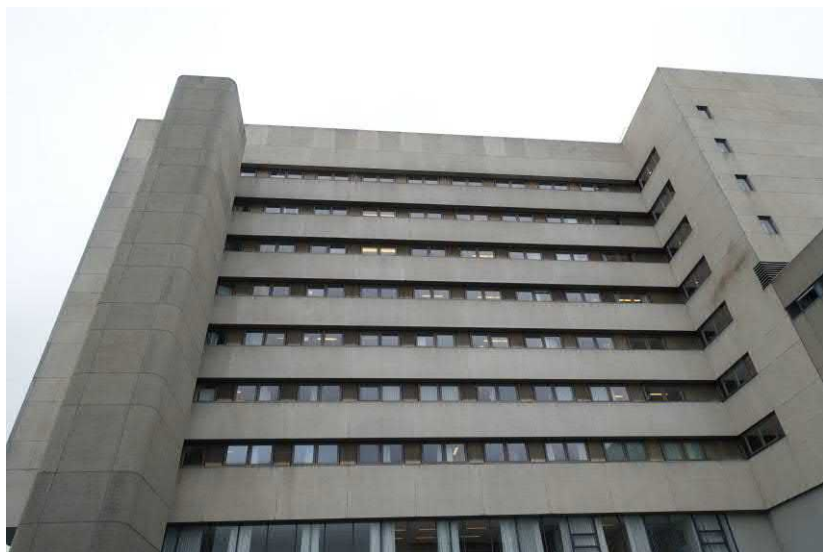
Gebouw 3 van het beddenhuis, overzicht van de noordgevel. FH MAB 2019
