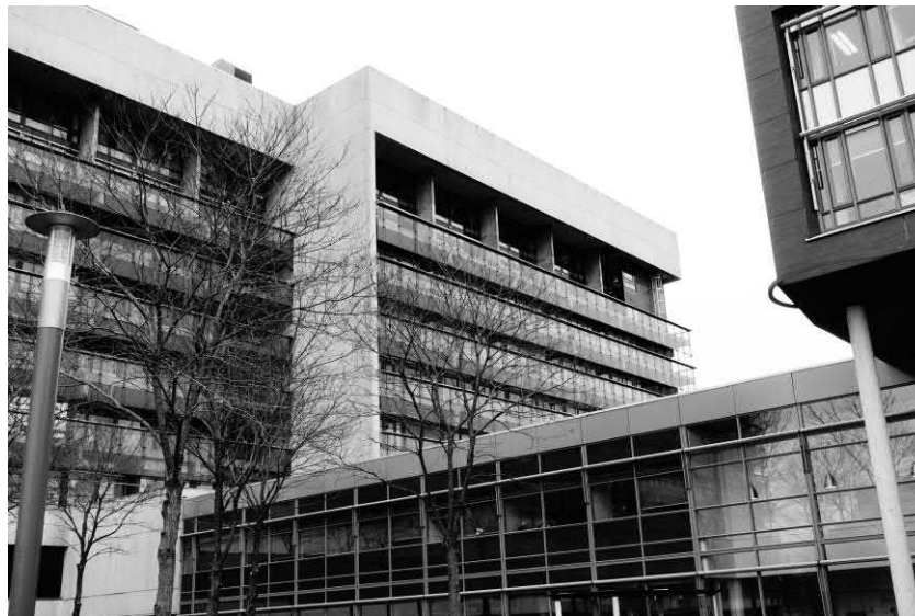
Gebouw 2 en 3 van het beddenhuis vanuit het zuidwesten. Op de voorgrond de met het beddenhuis verbonden gang van het in 2004 gebouwde GGZ en KG gebouw. FH MAB 2019
