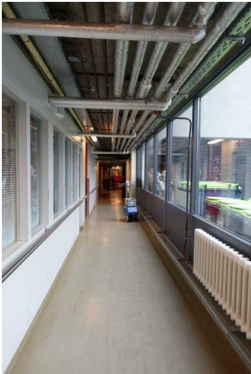
Keldergang aan de noordzijde in gebouw 3 naar het westen gezien. FH MAB 2019
