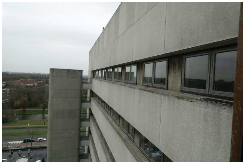
Gebouw 3 van het beddenhuis, zicht langs de bovendelen van de noordgevel naar het oosten. FH MAB 2019
