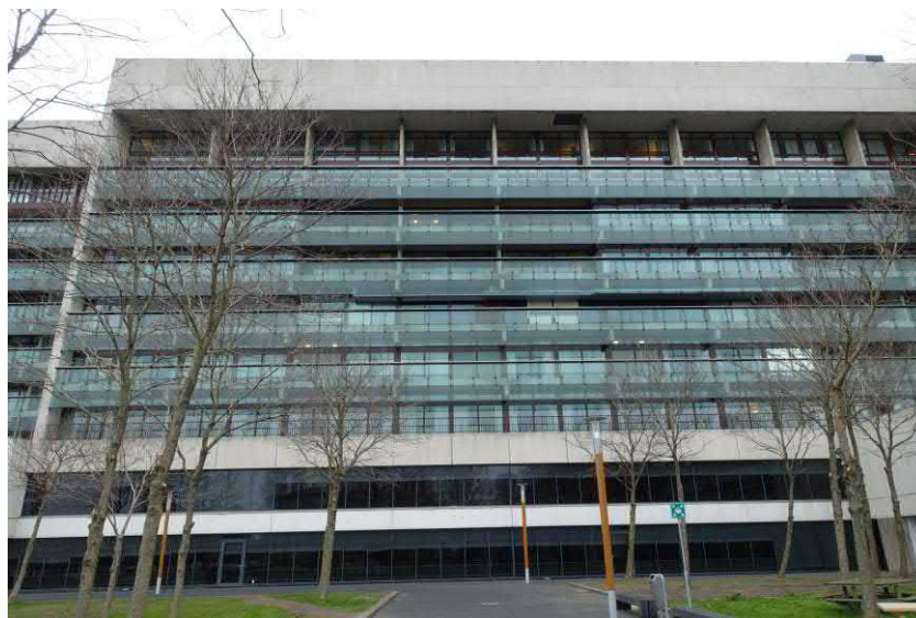
Gebouw 2 van het beddenhuis vanuit het zuiden. FH MAB 2019
