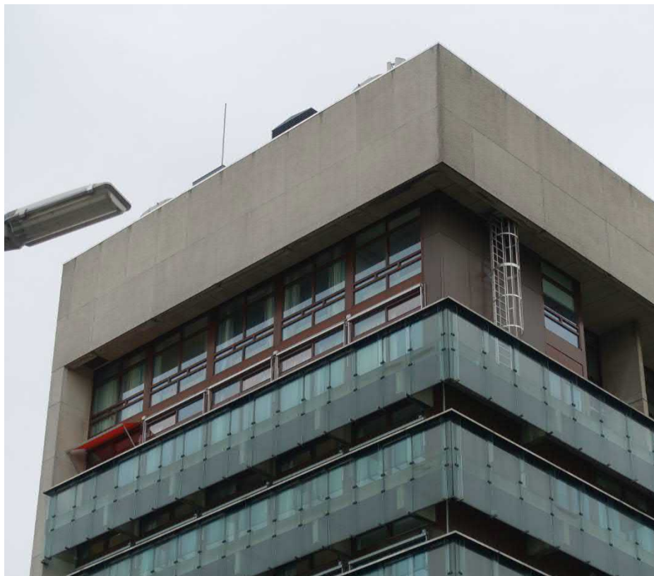
Bovendeel van de westgevel en zuidgevel van gebouw 1 van het beddenhuis. FH MAB 2019
