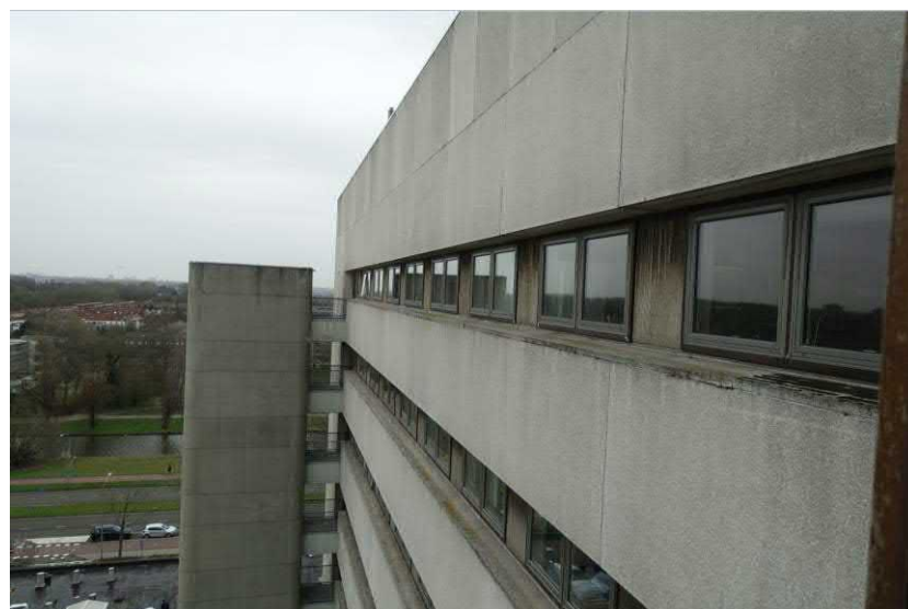
De noordgevel van gebouw 3 met vluchttraptoren is geheel als elementenbouw in betonplaten uitgevoerd. FH MAB 2019
