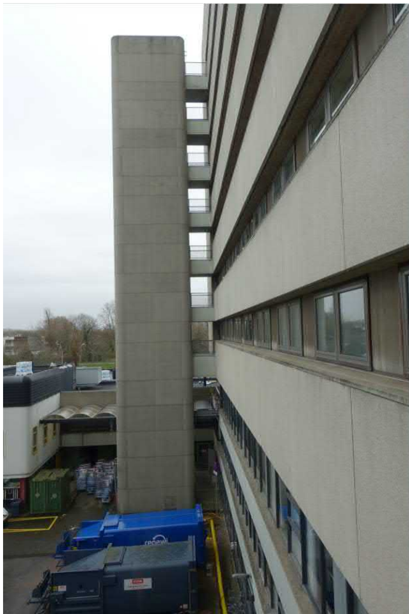
Gebouw 3 van het beddenhuis, zicht langs de noordgevel naar het oosten met op de achtergrond de noodtrappentoren met loopbruggen. FH MAB 2019
