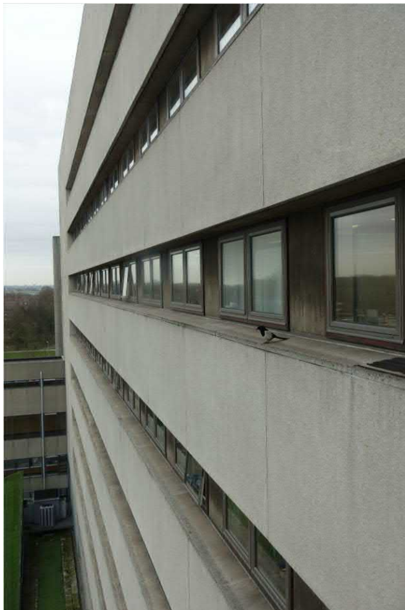
Zicht langs de noordgevel van gebouw 2, geheel opgebouwd uit prefab betonelementen (gevelplaten, dorpels e.d.). FH MAB 2019
