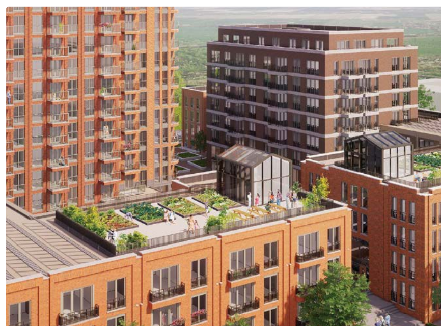
Daktuinen en PV-panelen
