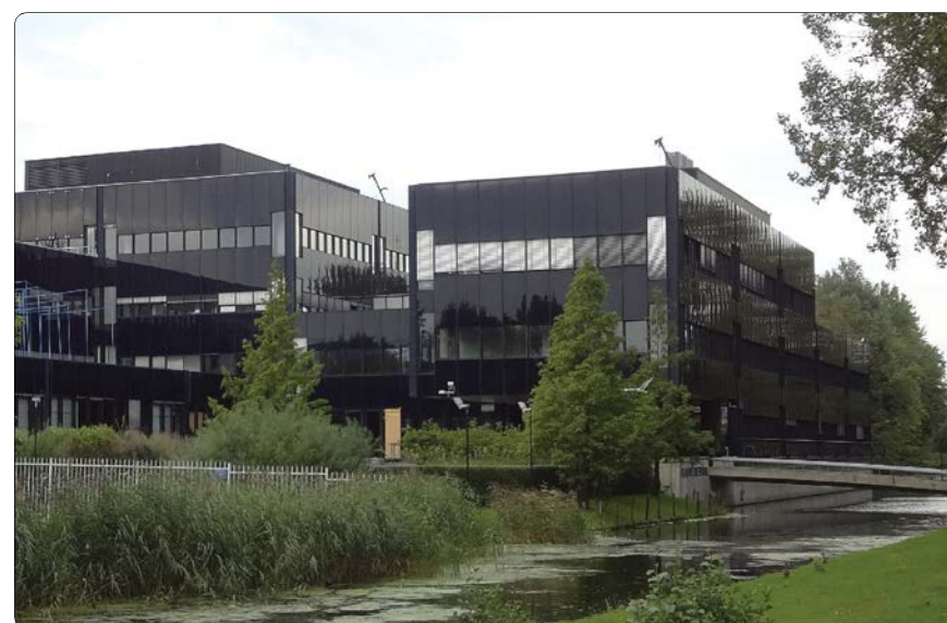
Bestaande kantoorgebouw Blauwe Wetering
