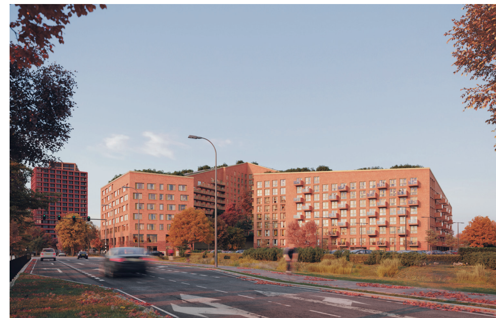
De buitenzijde van het blok is meer stedelijk van opzet. Hier wordt een rijkere variatie gezocht in gevelopeningen om de schaal en maat van het blok aan te sluiten op de omgeving en omringende bebouwing.
