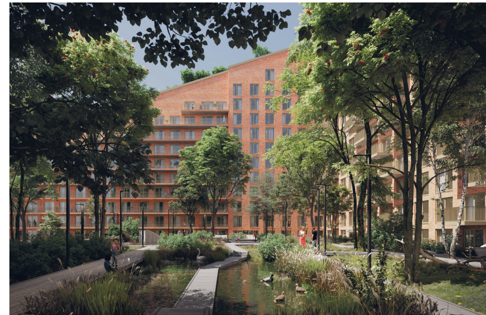
De binnengevels aan het blok zijn terughouden en eenvoudig van opzet, zodat deze niet concurreren met het krachtige groene landschap in de binnentuin
