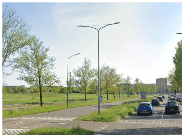
Figuur 1 Bestaande lichtmast 23-480, verplaatsen en kwartslag draaien
