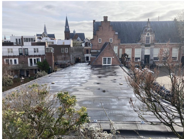
Nieuwe dakbedekking met verbeterde isolatie ( R_c = 6,0 W/m 2 )
