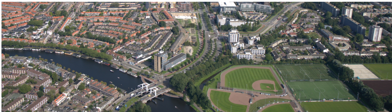
huidig karig beeld van de locatie: een stadssnelweg als barrière tussen verouderde bebouwing en een afgeschermd sport-
