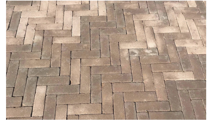
voetgangersdomein: gebakken klinker 'Mastiek' in verschillende formaten
