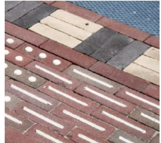
referentie: blindegeleidestroom als losse lijnen in steen
