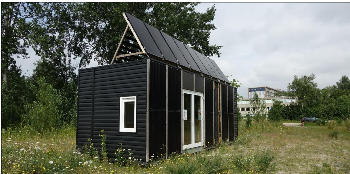
Figuur 8: Voorbeeld van een tiny house in het plangebied met de zonnepanelen op het dak.
