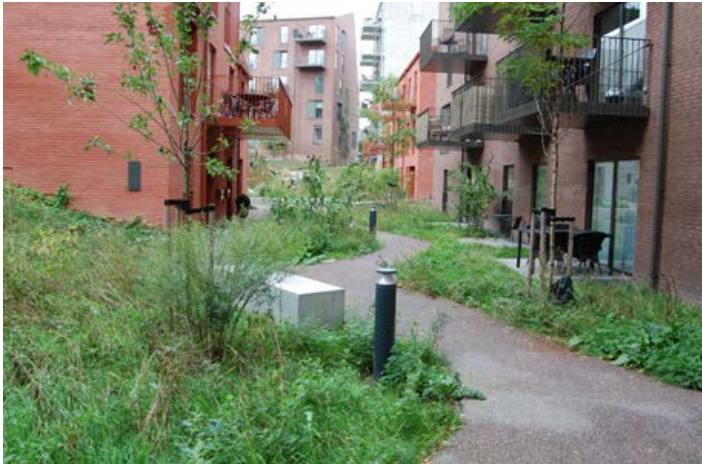
Informeel landschappelijke sfeer van buitenruimte, ook bij kleinere doorgangen Æbelø in Aarhus (Cebra architecten)
