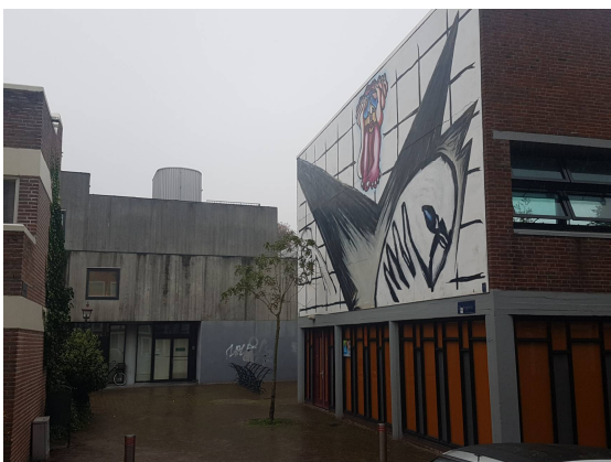
Entree vanaf Gedempte Voldersgracht naar parkeerkelder
