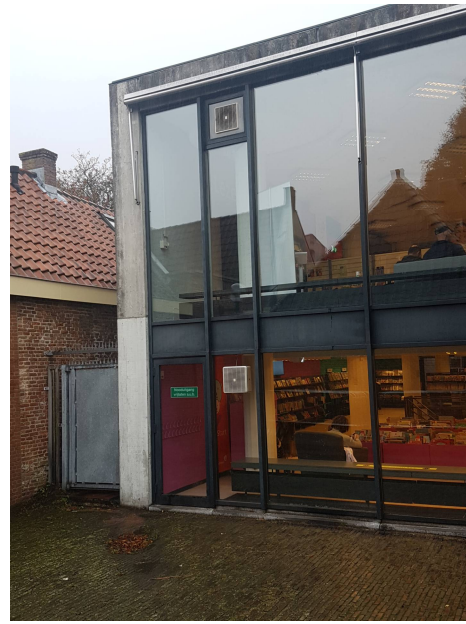
Zicht op seniorenhofje vanaf het plein
