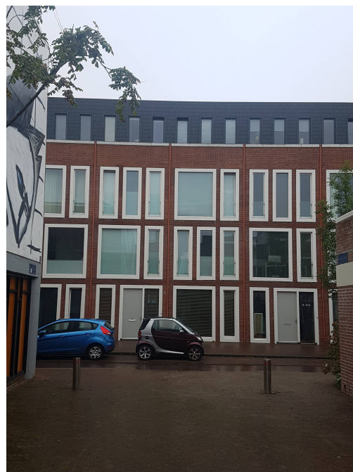
Gedempte Voldersgracht, referentie 4 laags appartementen
