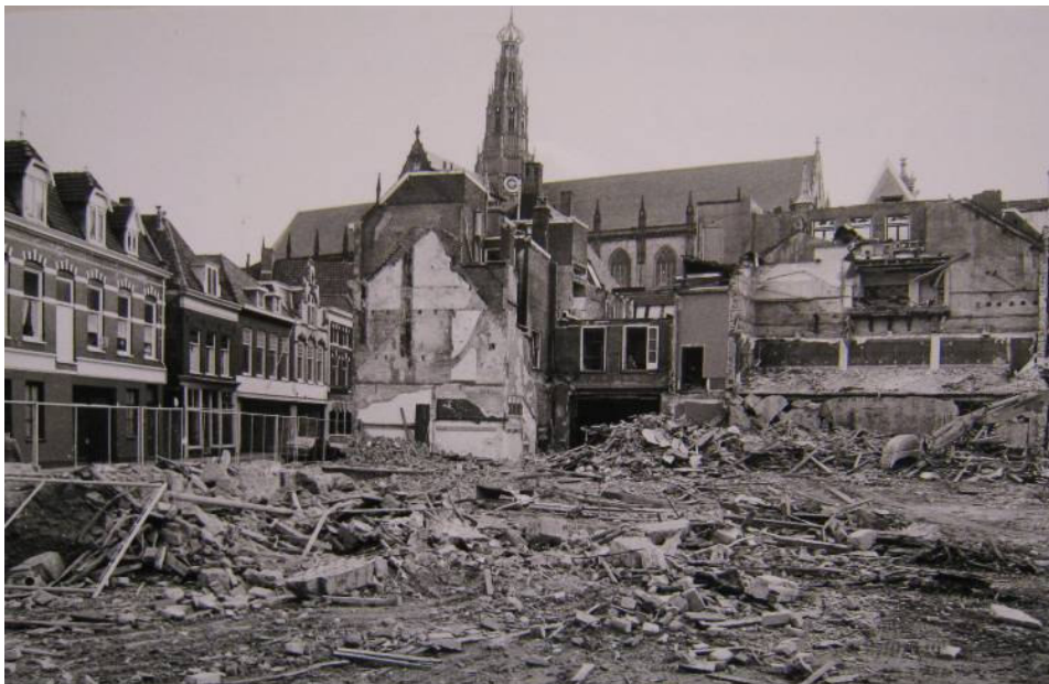
Sloopwerkzaamheden in februari 1978 achter Grote Markt 13-15. Links de Smedestraat
