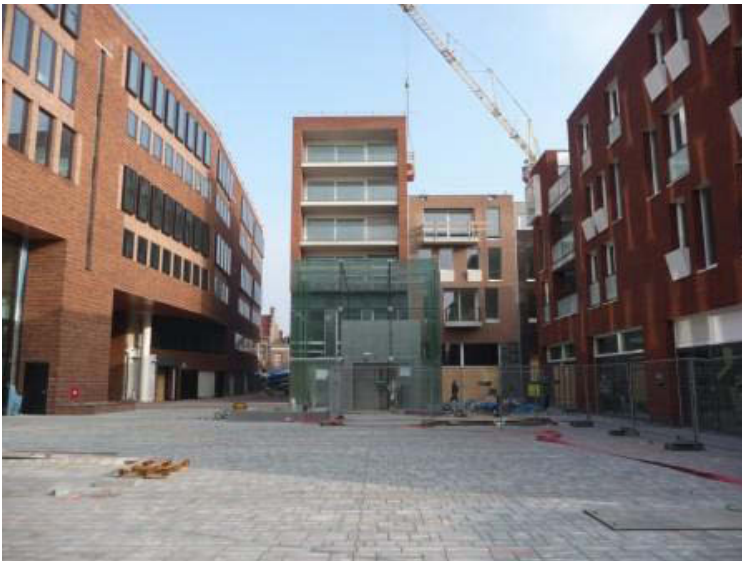
Binnenplein Raaks in aanbouw
