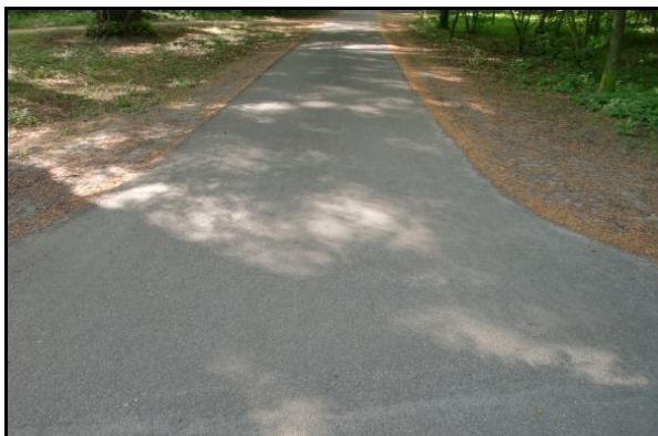
Fietspad in asfalt
