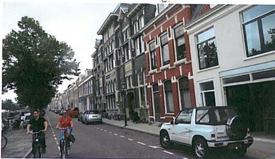
De voormalige R.K. Jongensschool St Joseph aan de Nieuwe Gracht vormt qua hoogte, breedte en kleurgebruik van grauwegele baksteen een opvallende verschijning in het verder vrij gelijkmatige 19 de -eeuwse gevelbeeld.
