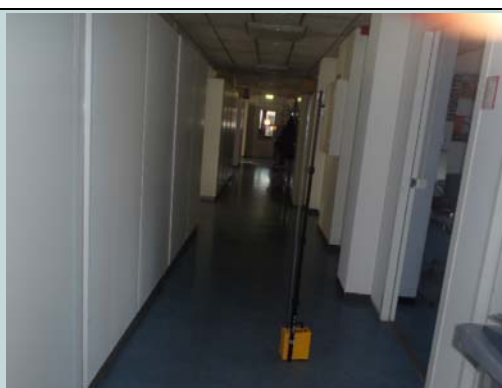
Pomp 8 in Gang 2e Verdieping bij ruimte 204
