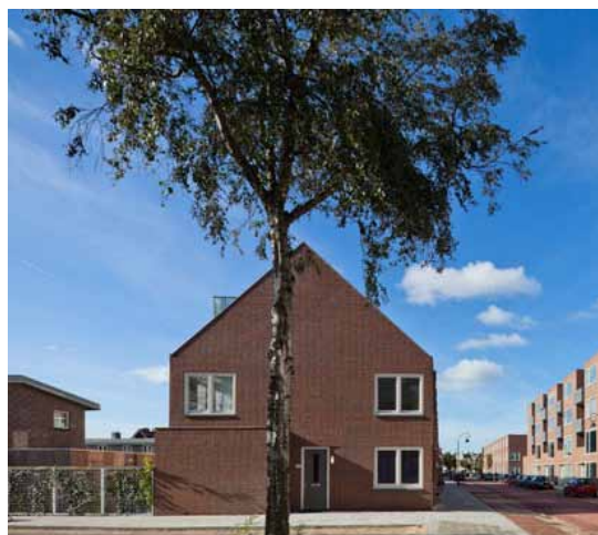
Woningentree op de kop van het blok
