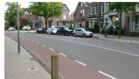
Foto 3.3.4: asfalt straat Noord (Ostadestraat.)
