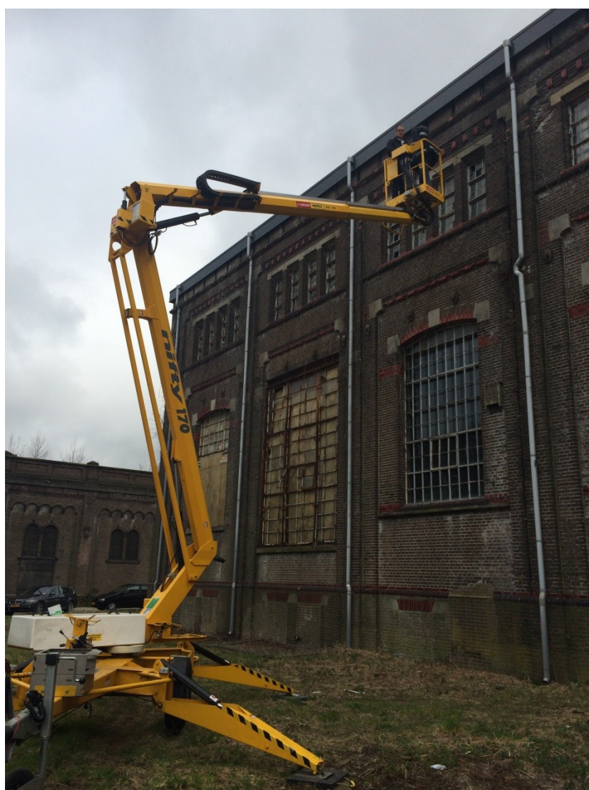
afb: inspectie console-ankers buitenzijde Turbinehal en stalen vakwerksparren binnenzijde Turbinehal.
