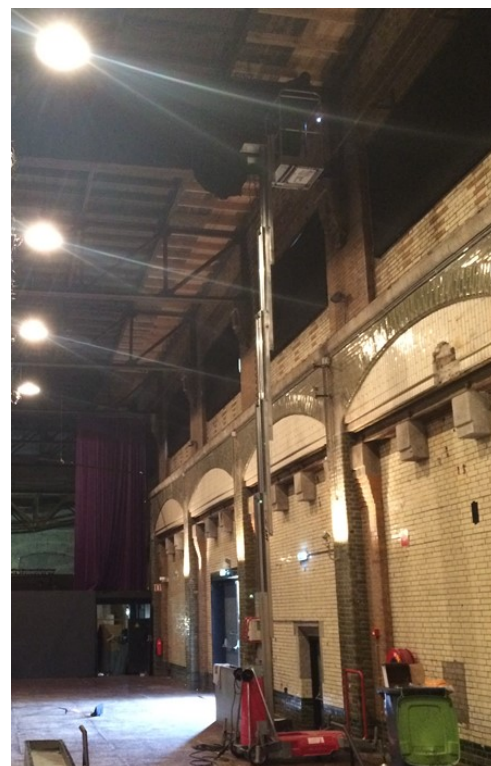
afb: inspectie console-ankers buitenzijde Turbinehal en stalen vakwerksparren binnenzijde Turbinehal.
