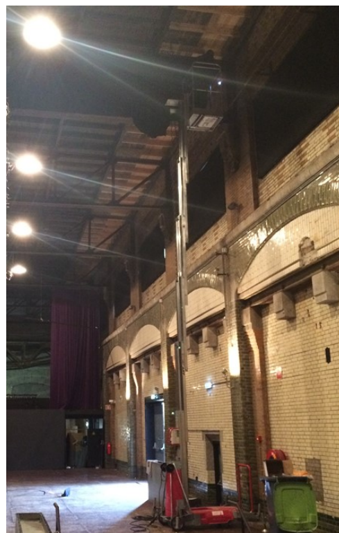
afb: inspectie console-ankers buitenzijde Turbinehal en stalen vakwerkspanten binnenzijde Turbinehal.
