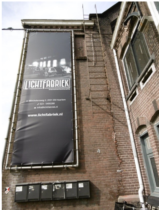
afb. boven: de doorgaande scheurvorming in de gevelaansluiting tussen het entreegebouw en het Oliehuis wordt middels een zgn. scheurmeter gemonitord
