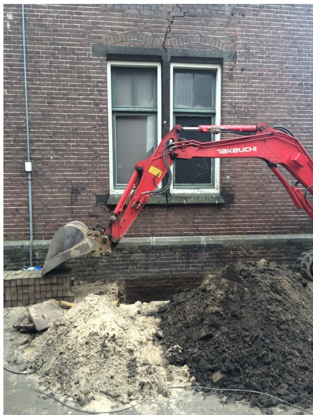
afb. boven: de doorgaande scheurvorming in de gevelaansluiting tussen het entreegebouw en het Oliehuis wordt middels een zgn. scheurmeter gemonitord
