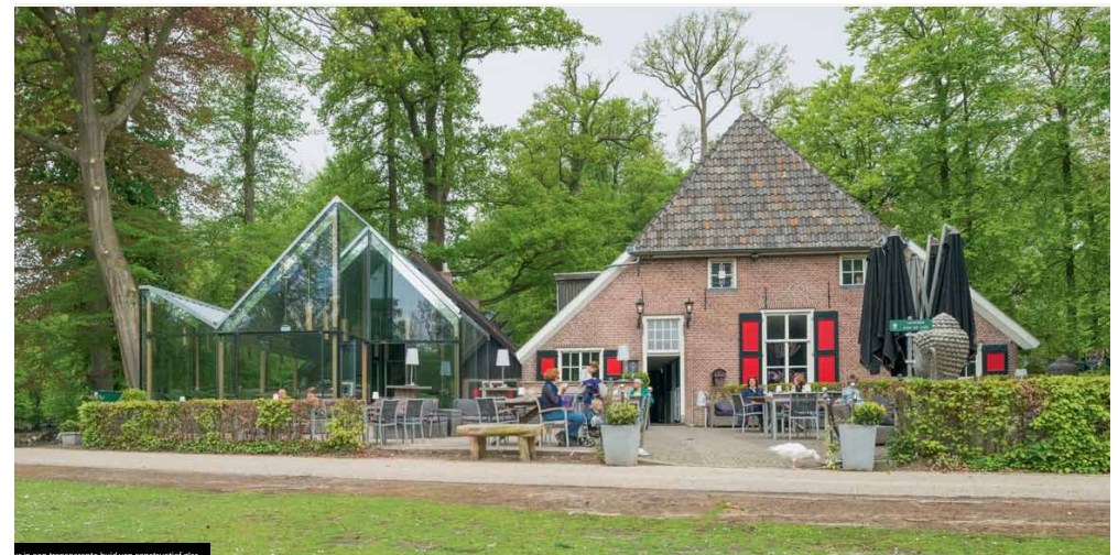
Uitbreiding Brasserie Sonsbeek - NEXIT architects
