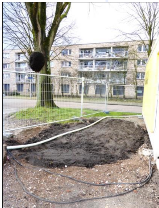
Foto 6: geroerde grond bouwdepot
