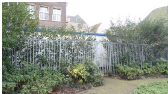
Verwijderen portocabins, verwijderen hek en beplanting tussen openbare en privetuin
