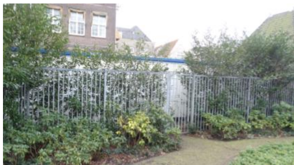
Verwijderen portocabins, verwijderen hek en beplanting tussen openbare en privétuin
