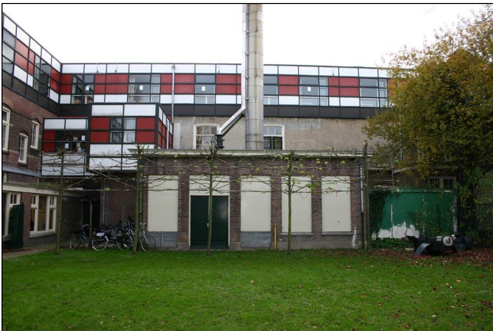
Afb. 47) De noordzijde van de zustervleugel. Van de noordgevel van de vleugel is enkel op de eerste verdieping muurwerk in het zicht (A). Mogelijk is dit gedaan om bouwsporen aan het zicht te onttrekken. Het is niet uitgesloten dat het achterliggende metselwerk dateert uit de 17 de eeuw of ouder. De vensters dateren waarschijnlijk uit 1871. De rechter is sinds ca. 1905 een doorgang om het balkon op het dak van het onderstaande ketelhuis (B) te kunnen gebruiken. Het ketelhuis dateert van rond 1905, maar heeft in 1928 de huidige gevelindeling gekregen (afb. 10). Op de verdieping bevindt zich aan de oostzijde een uitgebouwde 'proefkamer voor zusters' uit 1963 (C), die sinds de renovatie in 1976 als zodanig niet meer herkenbaar is. Toen heeft ook de tweede verdieping zijn huidige aanzien verkregen (D).
