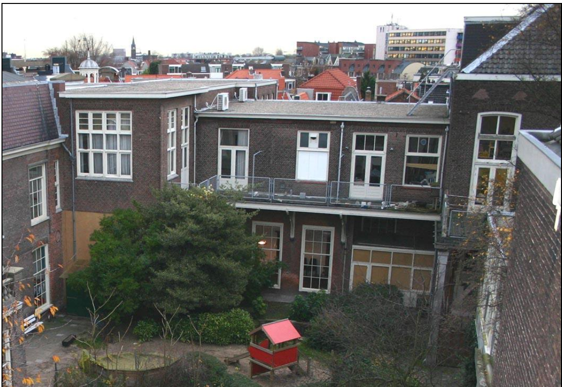
Afb. 34) Overzicht van de westzijde van de regenten- en keukenvleugel. Deze zijde kan verdeeld worden in een zuidelijk deel en een uitspringende noordelijk deel. Voor het zuidelijke deel en de zijkant van het noordelijke deel is op de verdieping een balkon aangebracht. Dit balkon is in fasen tot stand gekomen, overeenkomstig de gevels op de verdieping. Zo is het gedeelte bij het balkon dat op schoren rust (A) vermoedelijk rond 1905 tot stand gekomen. In 1924 is vervolgens het balkon naar het zuiden verlengd, toen op de verdieping een kinderzaal werd gemaakt (B, afb. 8). Het noordelijke deel van het balkon is gelijktijdig met het maken van een verdieping aan deze zijde in 1929 gerealiseerd (C, afb. 13). Op de begane grond dateert het muurwerk overwegend uit de 17 de eeuw (D), op het smalle zuidelijke deel na (E), dat vermoedelijk in het derde kwart van de 20 ste eeuw is ingevuld met een houten pui.
