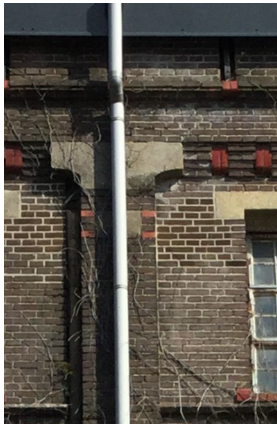
afb. fasen herstelwerkzaamheden console- -ankers Turbinehal
