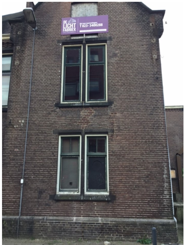
afb rechts: situatie na herstel
