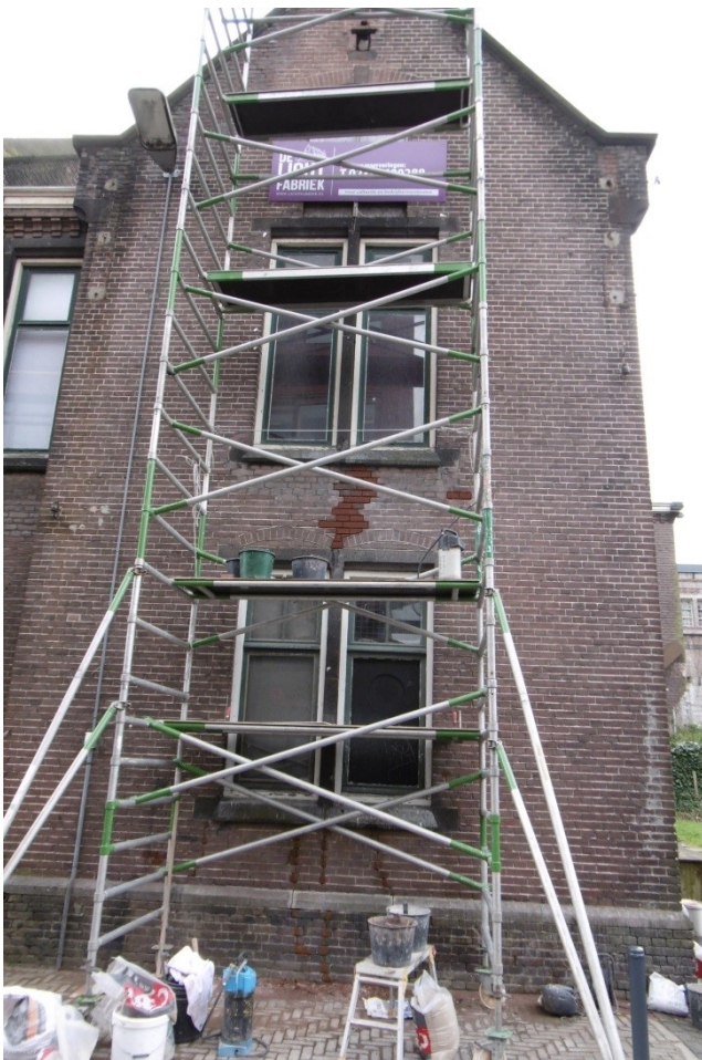
afb. links: herstelwerkzaamheden Energiehuis.
